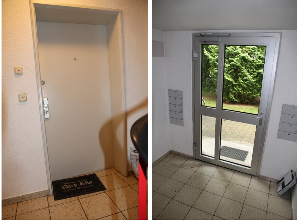
Innenansicht: Wohnungs- und Hauseingangstür
