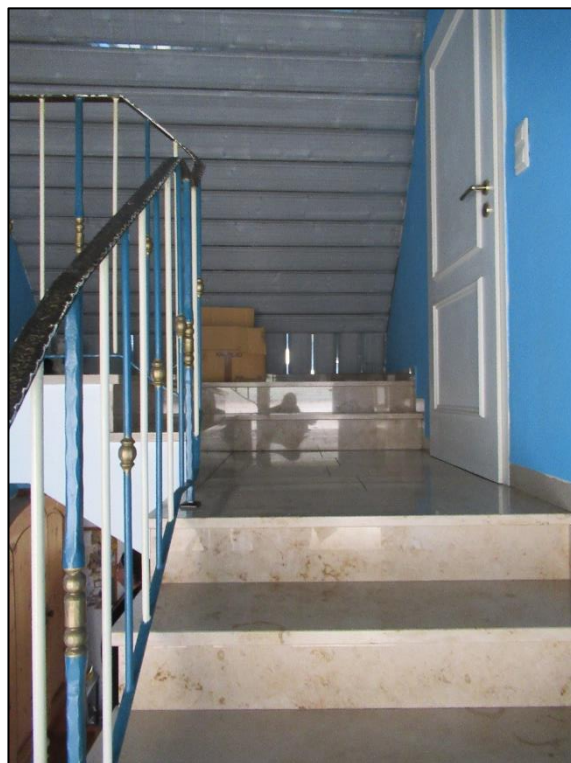
Obergeschoss / Dachgeschoss - Treppenpodest
