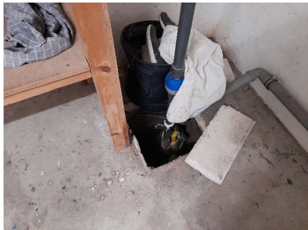
Kellergeschoss -Abwasser-Hebeanlage
