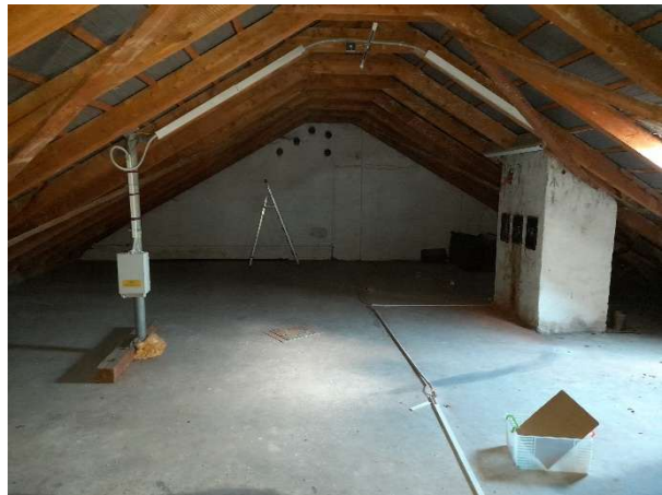
Dachgeschoss – Dachboden mit Dachstuhl
