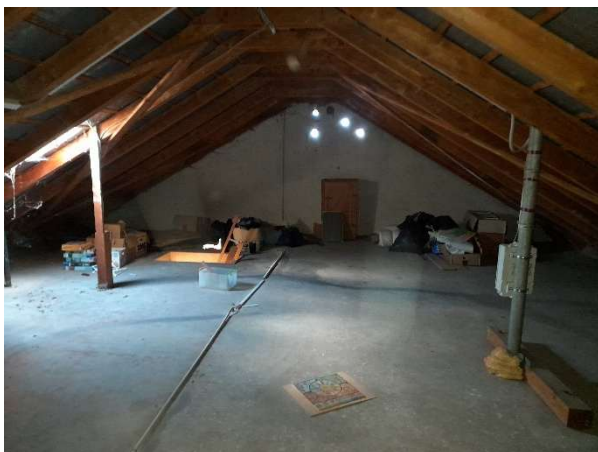
Dachgeschoss – Dachboden mit Dachstuhl
