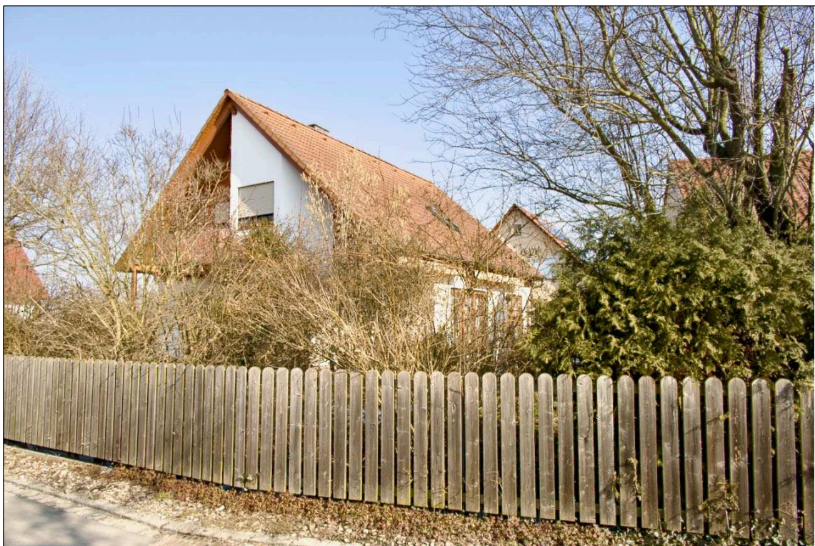
Foto 2 Straßenansicht von Westen
