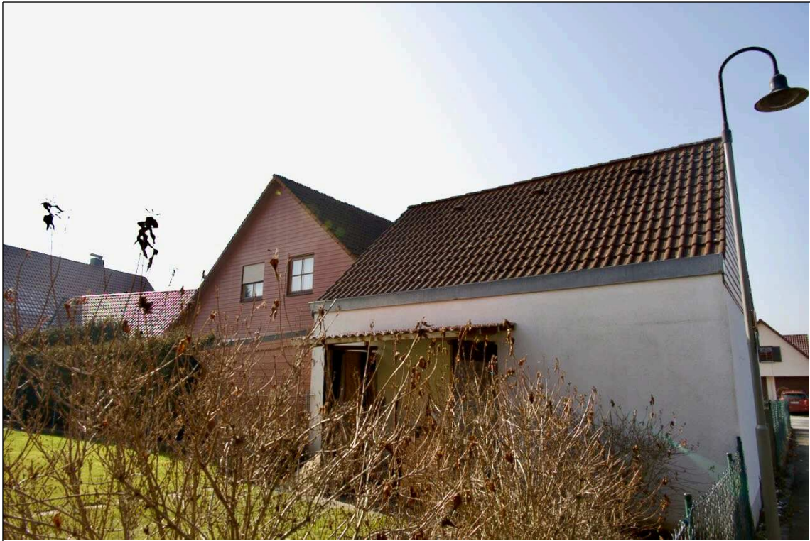
Foto 3 Ansicht von Osten
