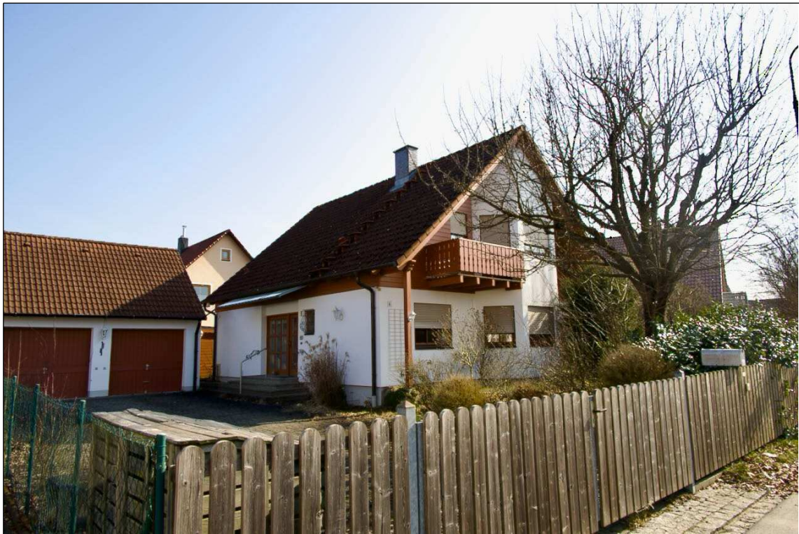
Foto 1 Straßenansicht von Westen
