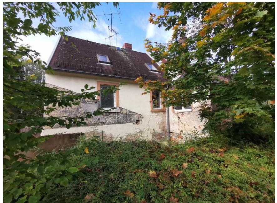
Blick auf den Gebäudeanbau auf der Ostseite des Gebäudes. Dacheindeckung des Anbaus als einfache Blecheindeckung. Das Wohnhaus verfügt über eine Dacheindeckung mittels einfacher Bitumendachschindeln
