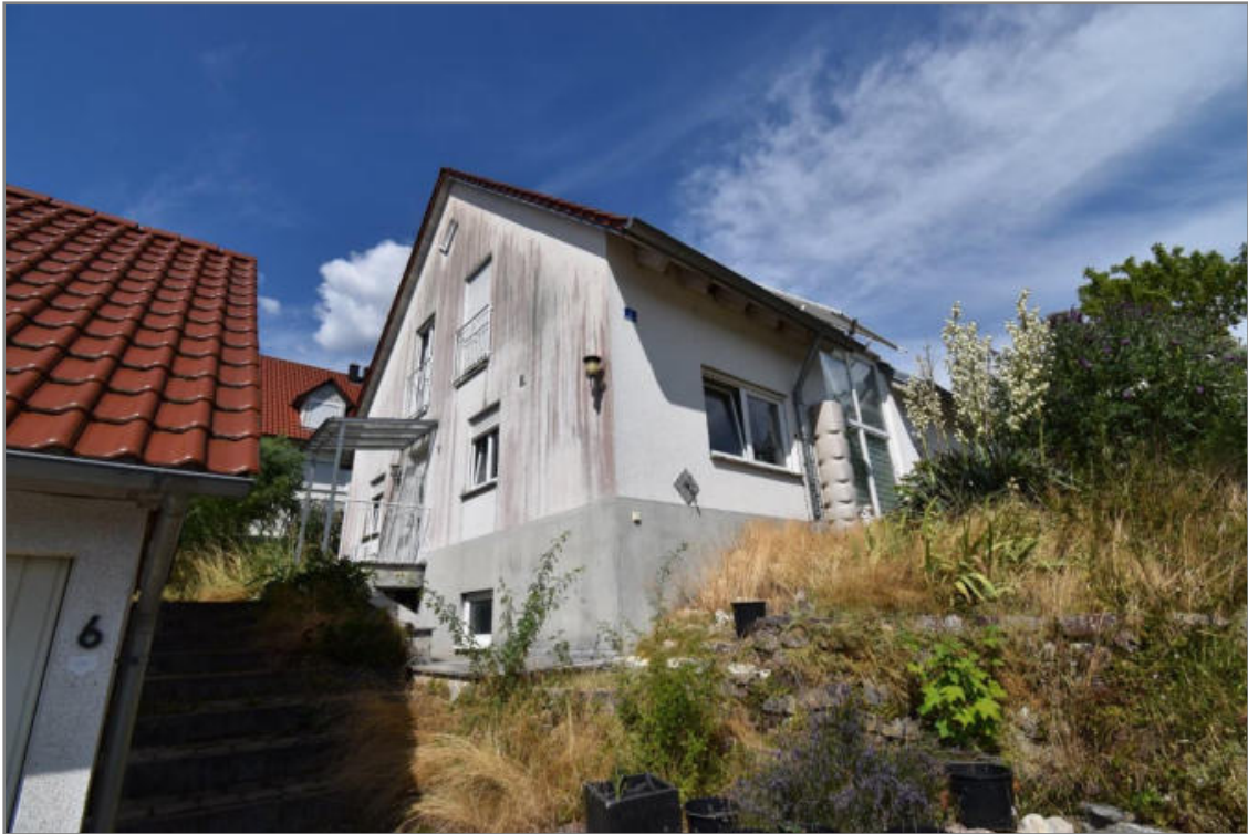
Blick nach Nordosten auf das Wohnhaus
