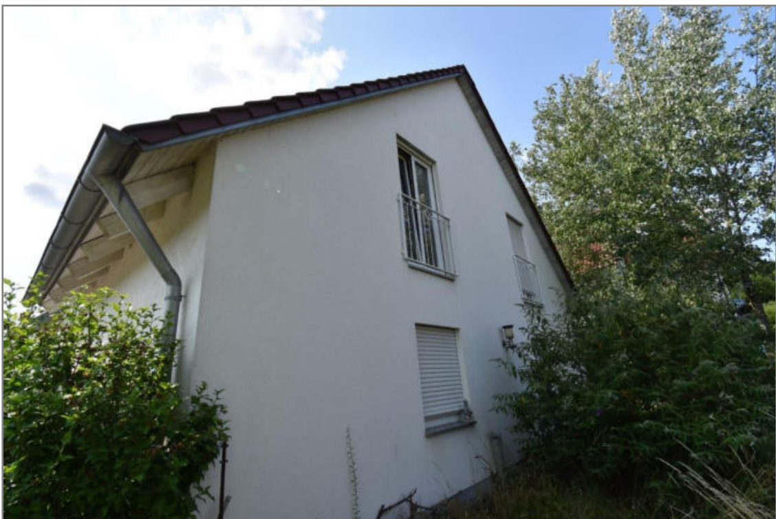
Blick nach Nordwesten auf die östliche Giebelseite des Wohnhauses
