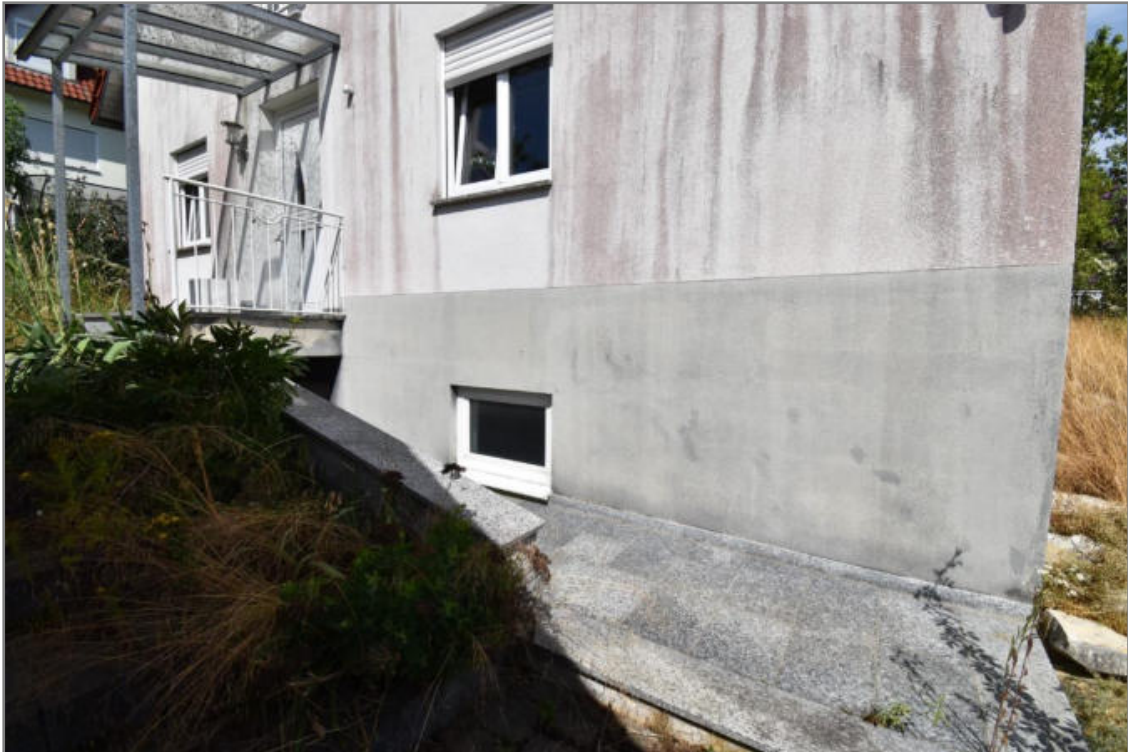
Blick nach Nordosten auf die Kelleraußentreppe
