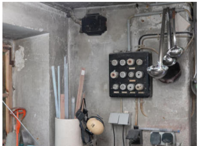
Beispiel Elektrosicherungen in der Werkstatt 1
