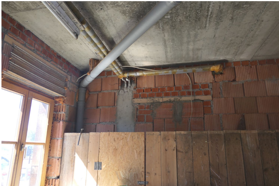
Bild 10: Innenwand, Geschossdecke und Installationen
