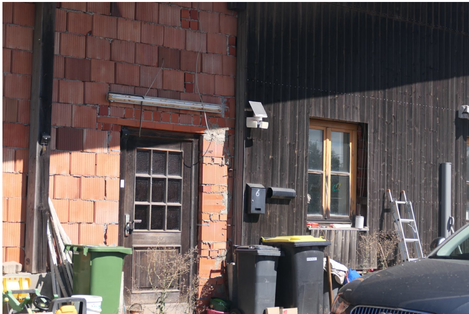
Bild 2: Eingangsbereich zur Wohnung und zu den Aufenthaltsräumen und Haustechnik
