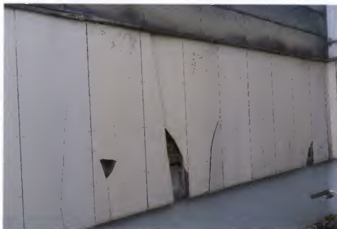
Schadhafte Fassadenplatten
