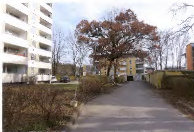
Zufahrt zu den Garagen / Weg zum Hauseingang
