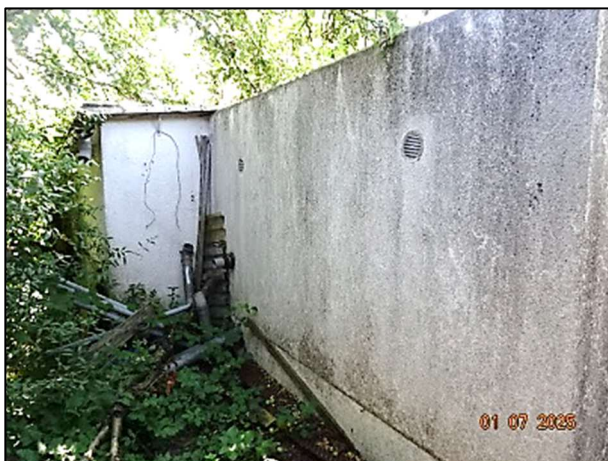
Außenputzschäden Garage Westseite
