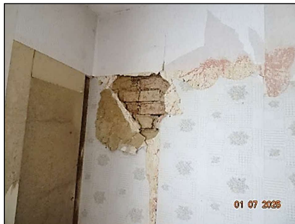
Putzschaden EG (Vollziegel)
