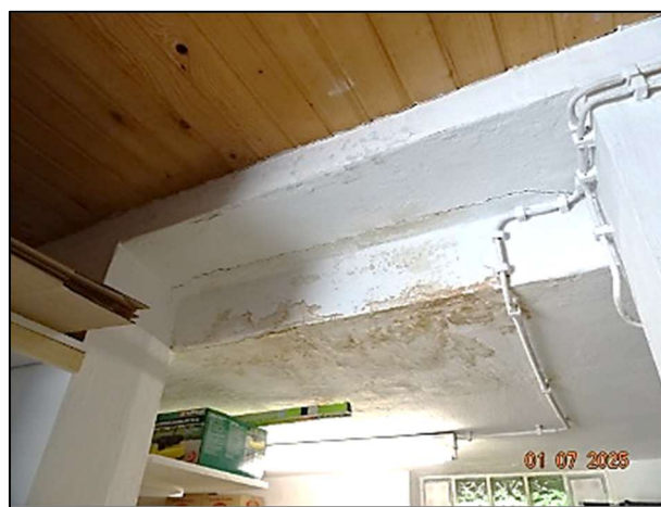
Feuchtigkeitsfleck bei Lager EG
