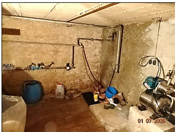
Kellerraum mit Feuchtigkeitsschäden
