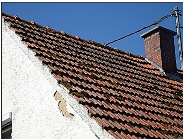
alte Falzziegel-Dachdeckung, Putzschäden Ortgang
