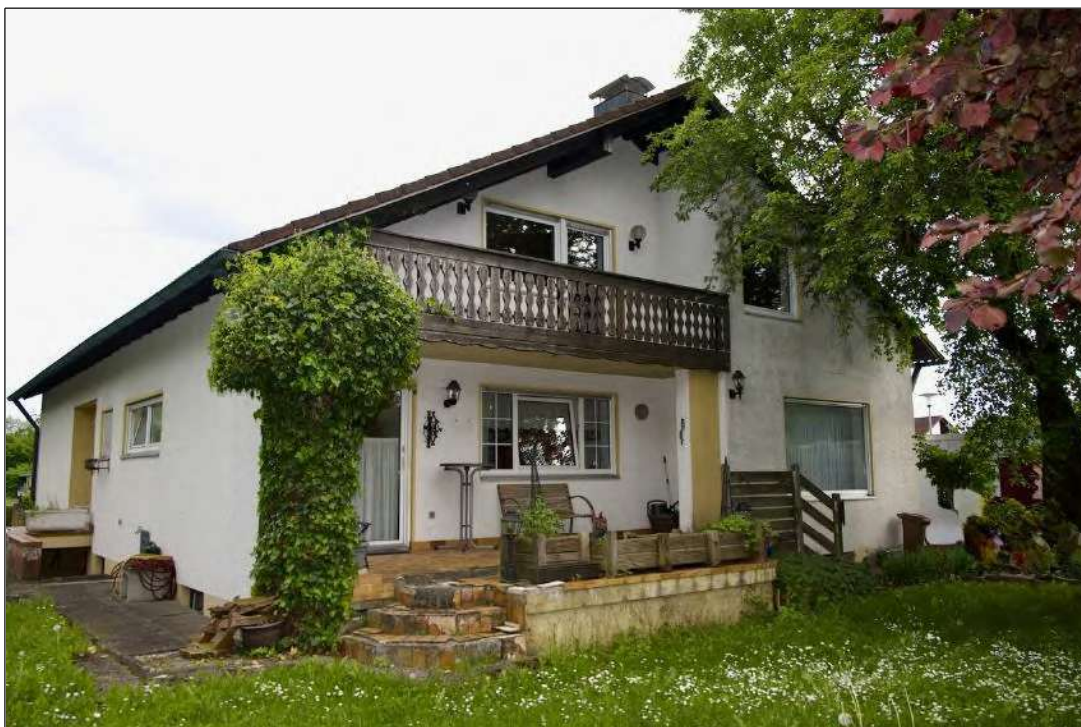
Foto 4 Ansicht von Westen
