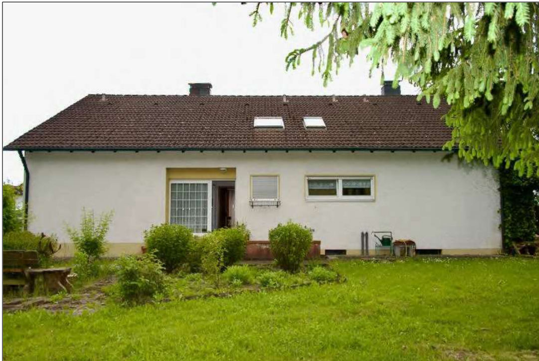
Foto 3 Eingangsansicht von Norden
