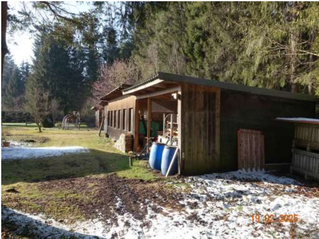
Abbildung 9: Schuppen bzw. Kleintierstall entlang der nördlichen Grundstücksgrenze
