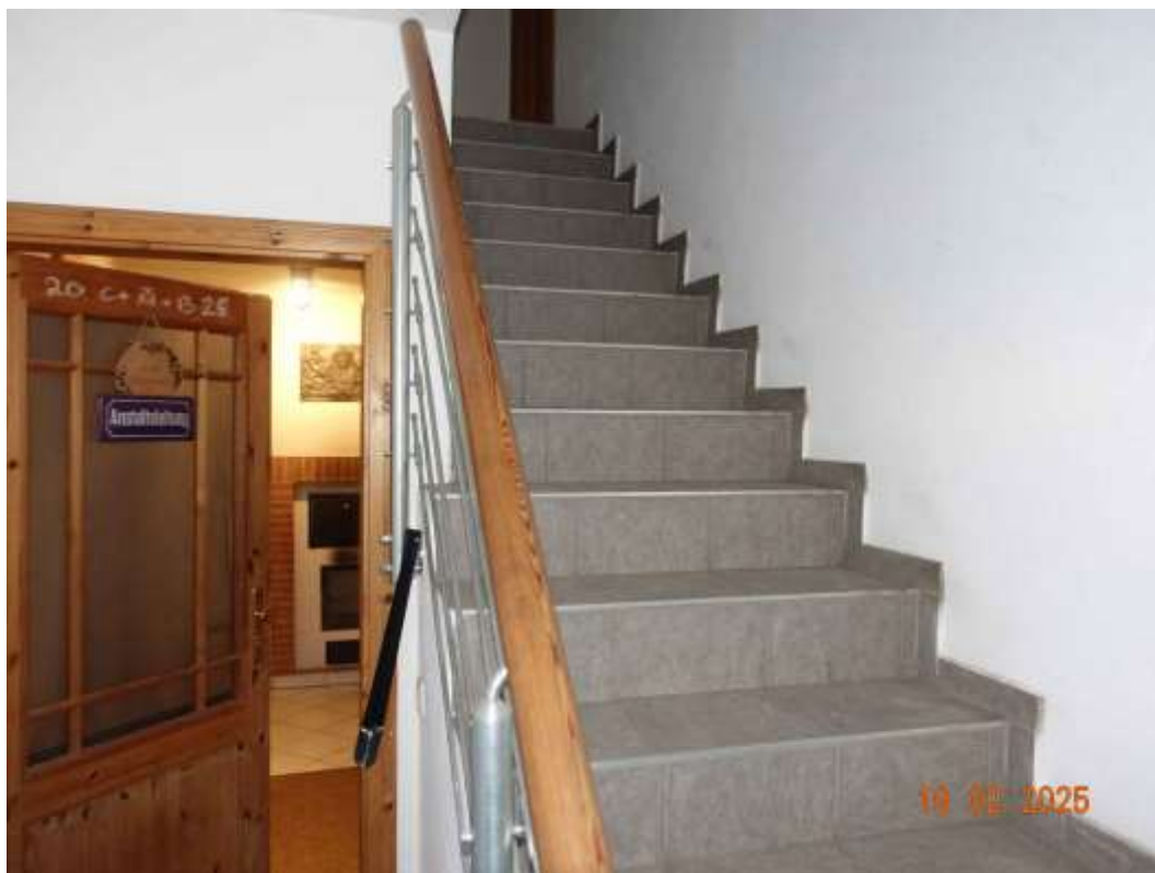
Abbildung 15: Wohnungsabschlusstür zur Wohnung Nr. 1 im EG und Treppenführung
