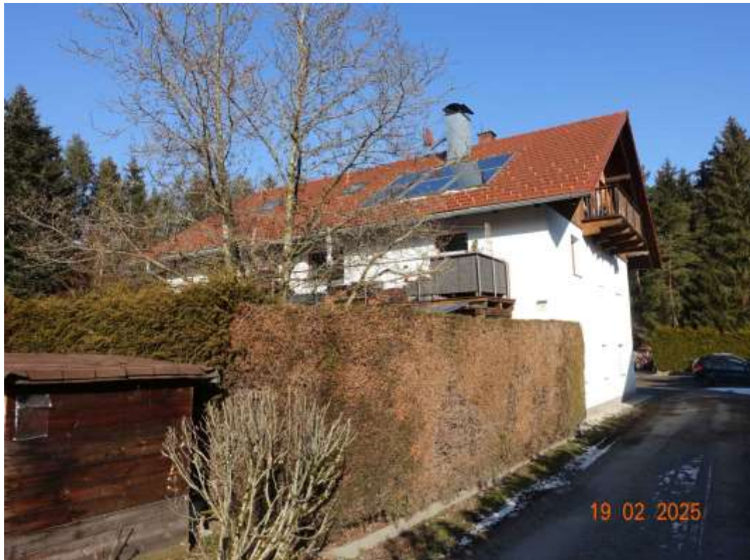
Abbildung 3: Wohnhaus mit vier Eigentumswohnungen entlang der Zufahrt
