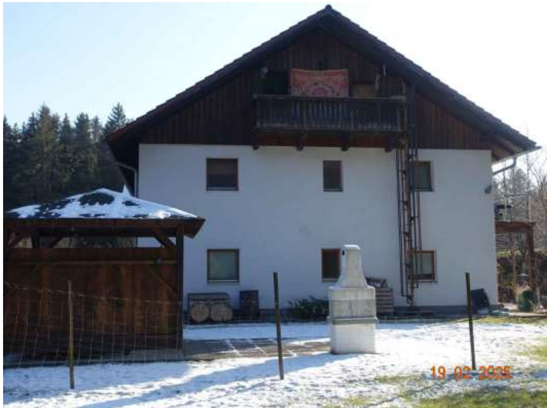
Abbildung 13: Nördliche Giebelseite des Wohnhauses mit Feuerleiter zum Balkon im DG
