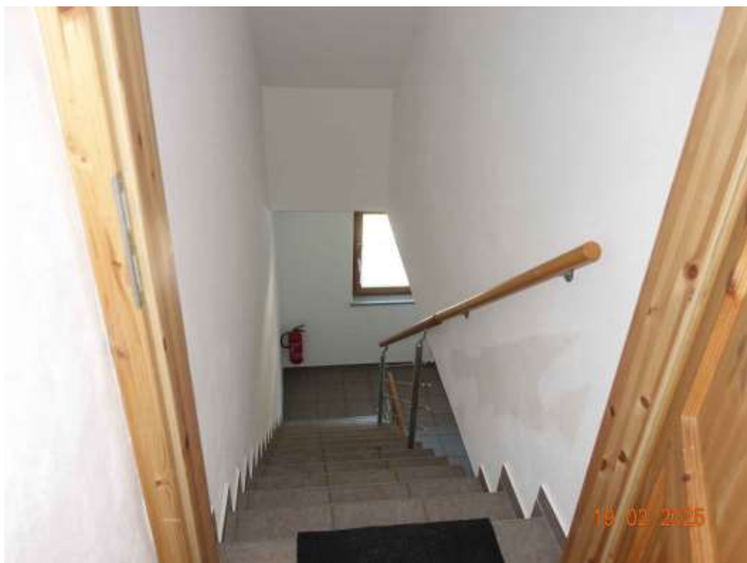
Abbildung 24: Treppenführung in das Dachgeschoss mit Wohnung Nr. 4
