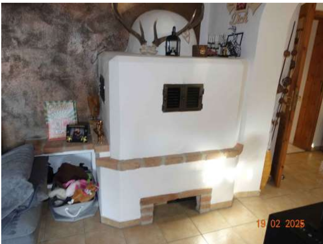
Abbildung 20: Kachelofen im Wohnraum der Wohnung Nr. 1, sonst elektrische Heizkörper
