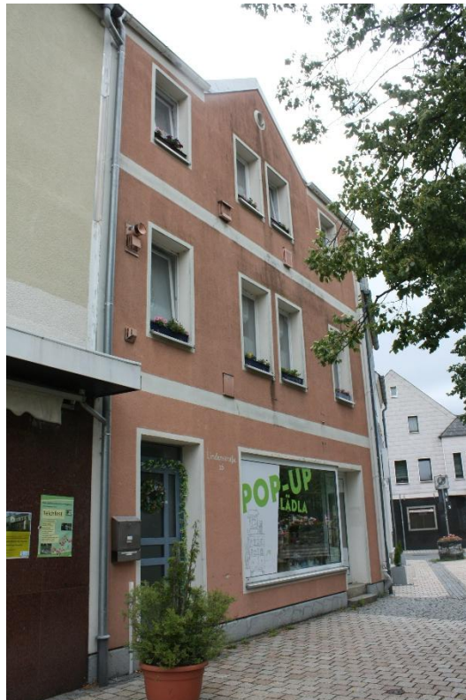
das Wohn- und Geschäftshaus
