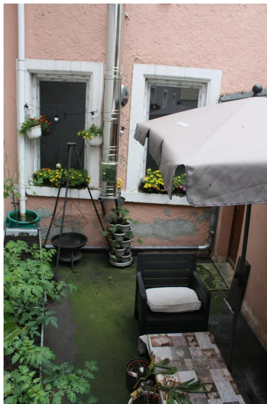
Blick in den kleinen Innenhof im Norden des Grundstücks, sichtbar der Edelstahlkamin der Erdgasheizung
