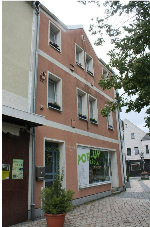
das Gebäude von der Lindenstraße aus gesehen
