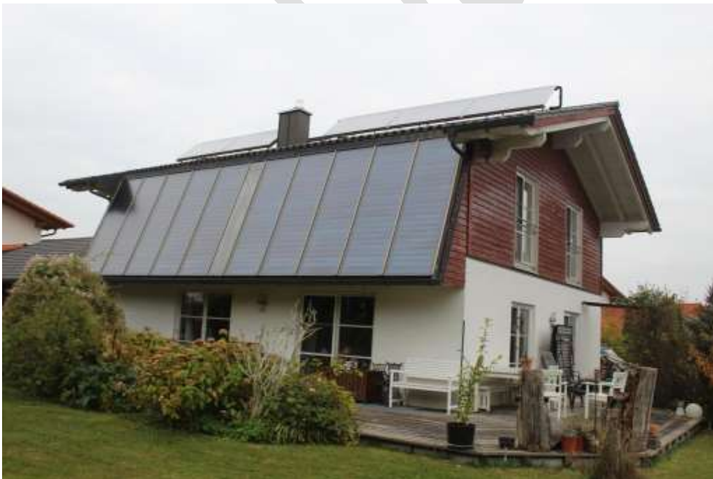
Abb. 4: Südostansicht – Solarkollektoren an der Südfassade und auf dem Dach
