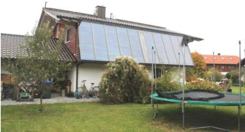
Abb. 3: Südansicht mit Solarkollektoren
