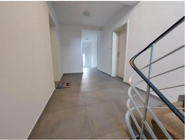
Erdgeschoss Flur mit Eingang und Treppenhaus
