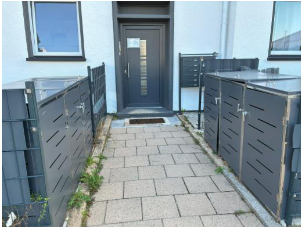
Hauseingang mit Briefkästen und Mülltonnenanlage
