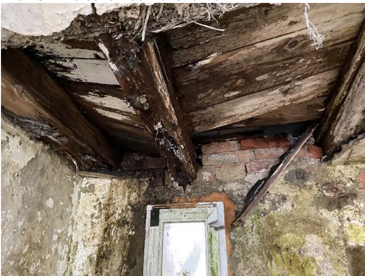
Bild 16 – morsche Dachkonstruktion
