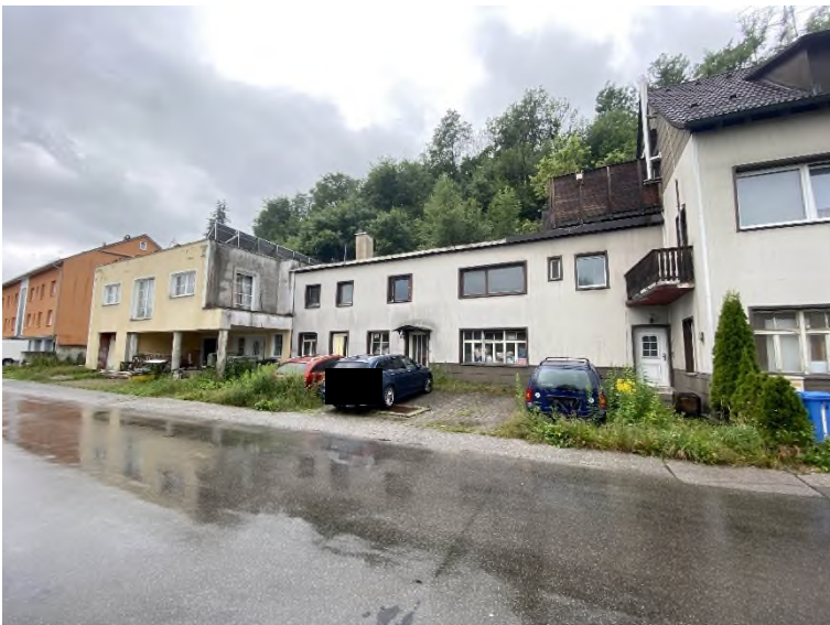
Bild 3 – Mitteltrakt und Südtrakt von Nordost
