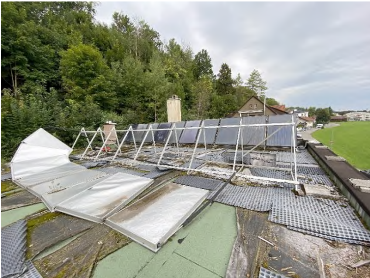
Bild 8 – Blick auf Flachdach Südtrakt
