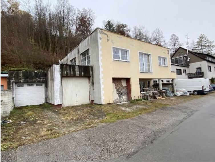
Bild 5 – Südtrakt von Südost im OG
