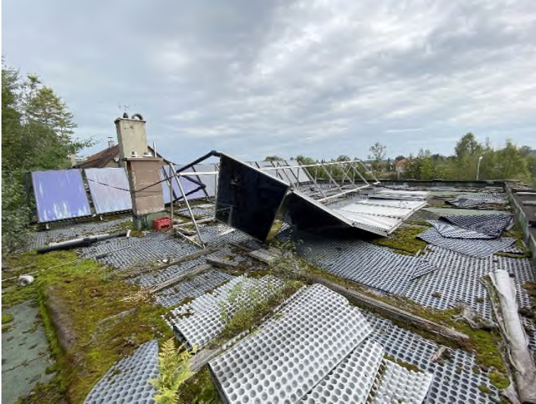
Bild 7 – Blick auf Flachdach Südtrakt
