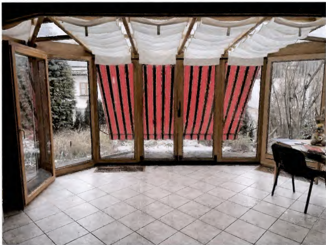
Wintergarten mit Lüftungsöffnungen
