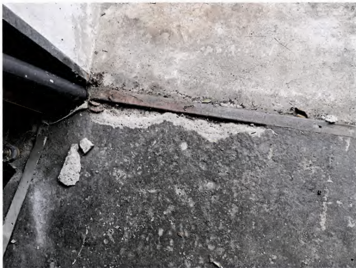
Boden im Bereich des Garagentors
