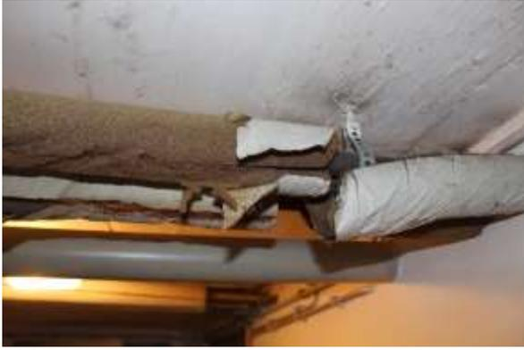
**Abb. 52:** Schadhafte Rohrisolierungen
