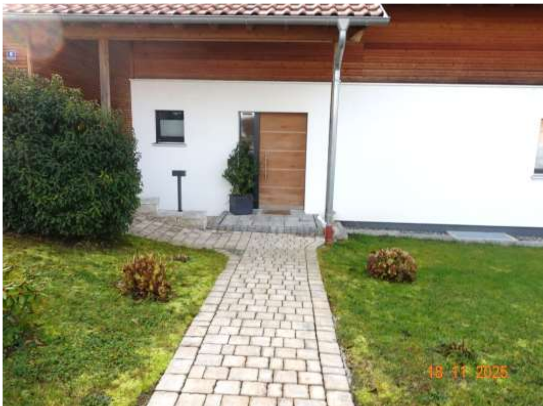
Abbildung 6: Zugang zum Wohnhaus mit Vordach an der Hausabschlussstür
