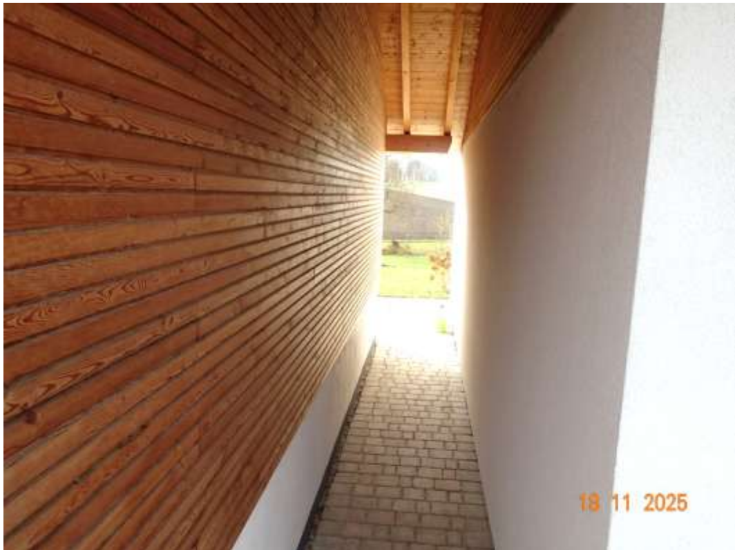
Abbildung 5: Überdeckter Durchgang zwischen Doppelgarage und Wohnhaus
