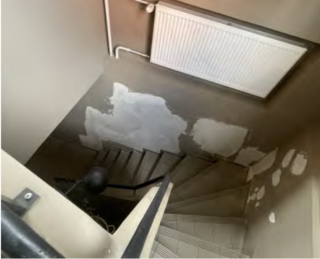
Treppenabgang Gastraum EG in das KG, Auswirkungen und Spuren von eindringender Feuchtigkeit an der Gebäudeaußenwand
