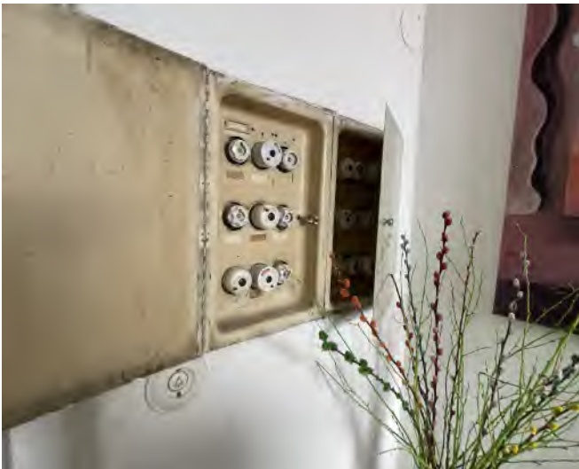
Alte Schraubsicherungen
