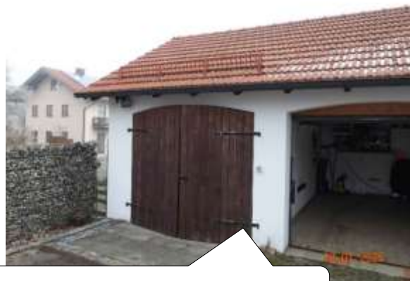
Nördliche Garage mit Satteldach
