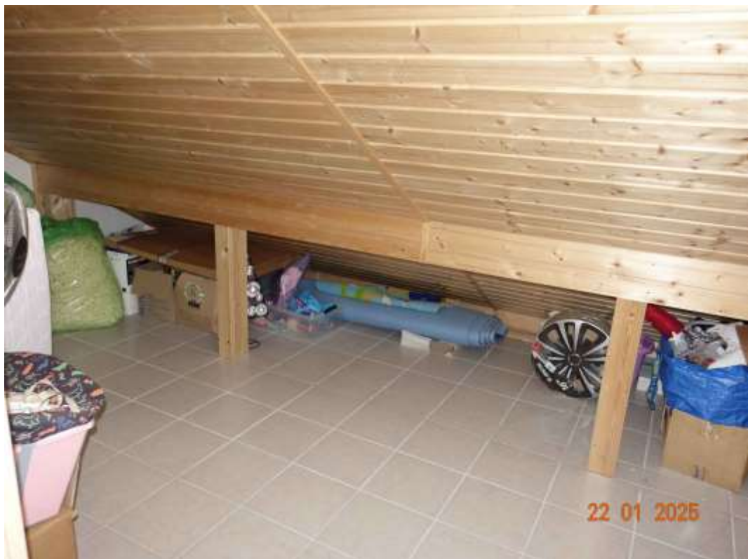
Abbildung 22: Dachbodenraum rechts der Treppenführung
