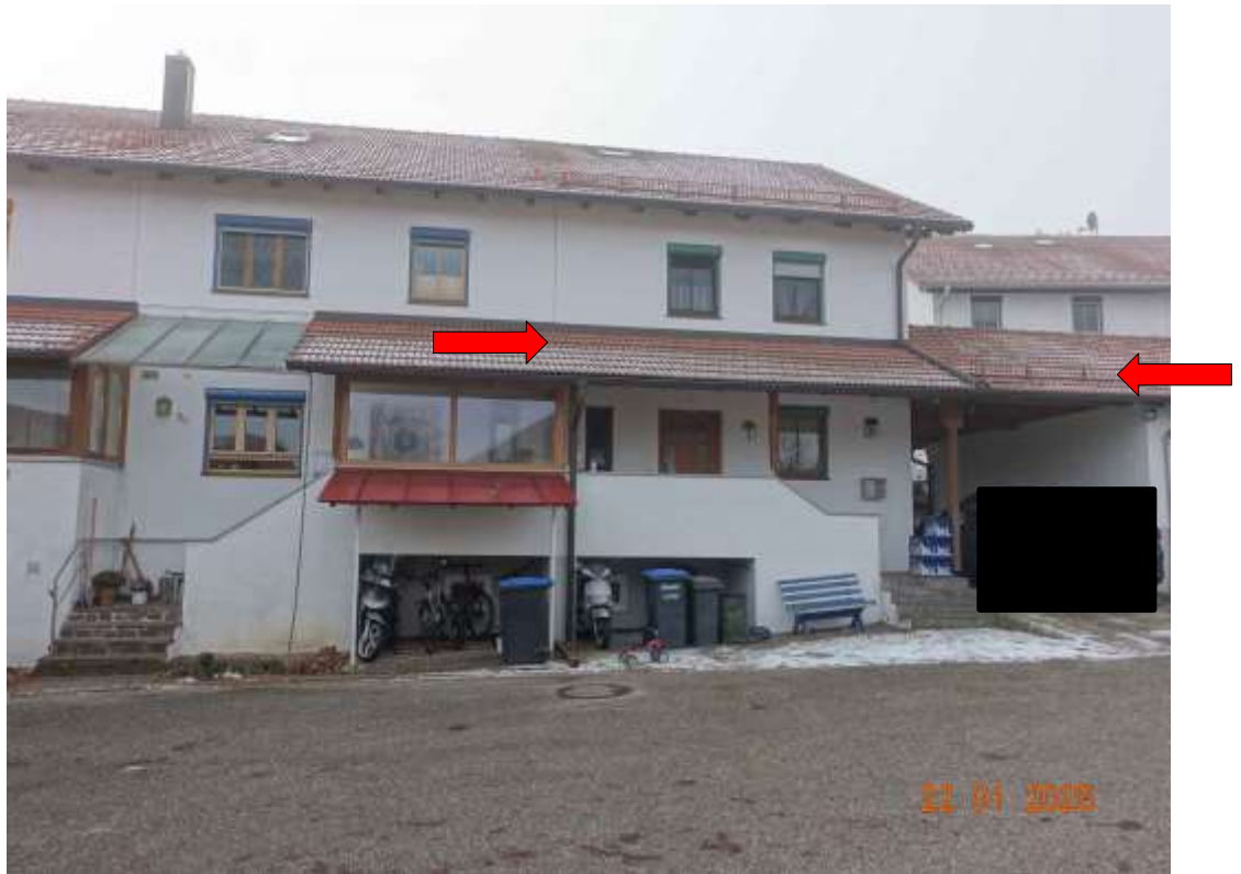
Abbildung 3: Reihenendhaus mit Eingangsüberdeckung und Carport
