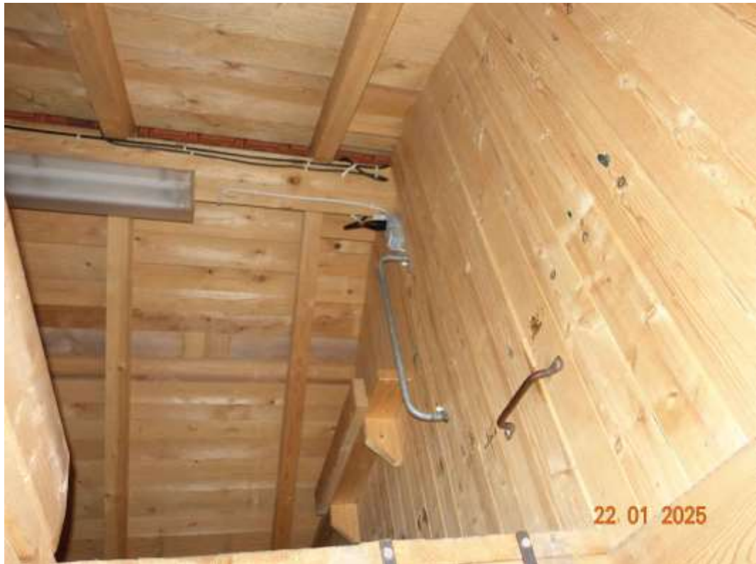
Abbildung 27: Dachbodenraum im Satteldach der Garage
