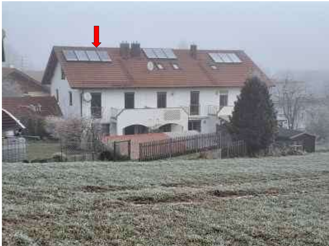
Abbildung 1: Ansicht Dreispänner von Südwesten
