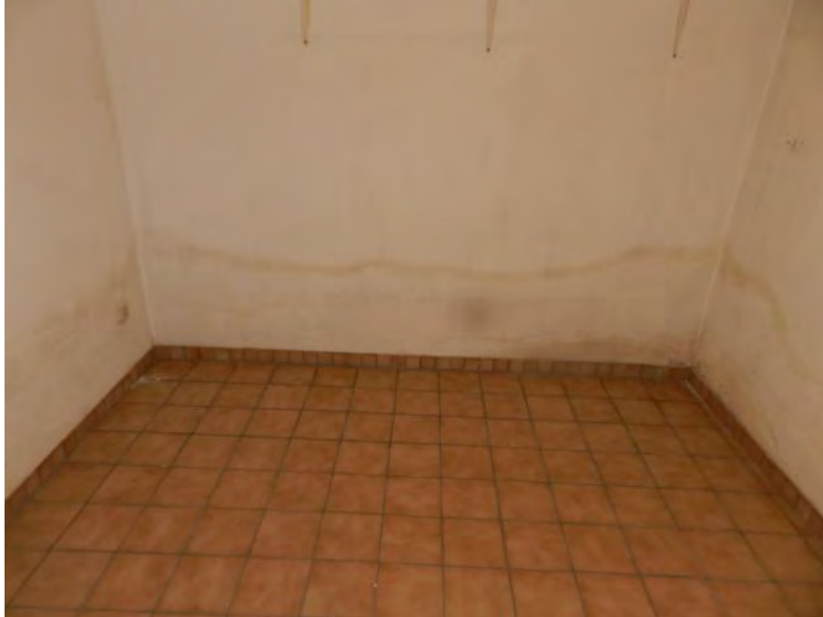
Wohnhaus Fl.-Nr. 2243/3, Kellerraum, Wände mit Anzeichen von Feuchtigkeit
