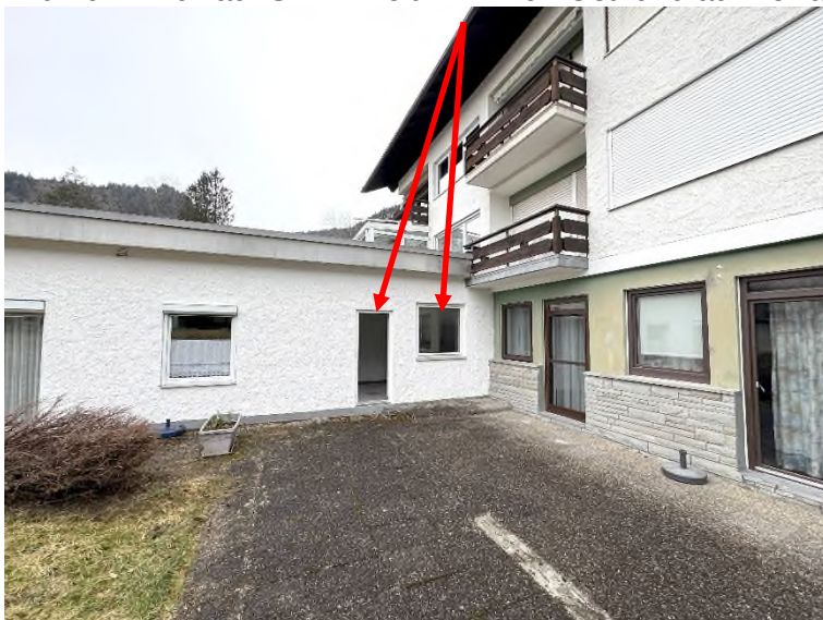
Bild 19 – Blick auf SE-Einheit Nr. 2 von Ost und auf Terrasse
