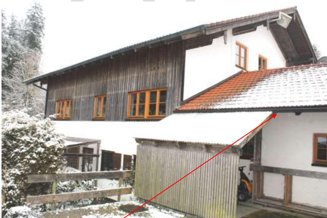
Abb. 9: Nordwestansicht, Nachbargebäude auf FINr. 2110/1
