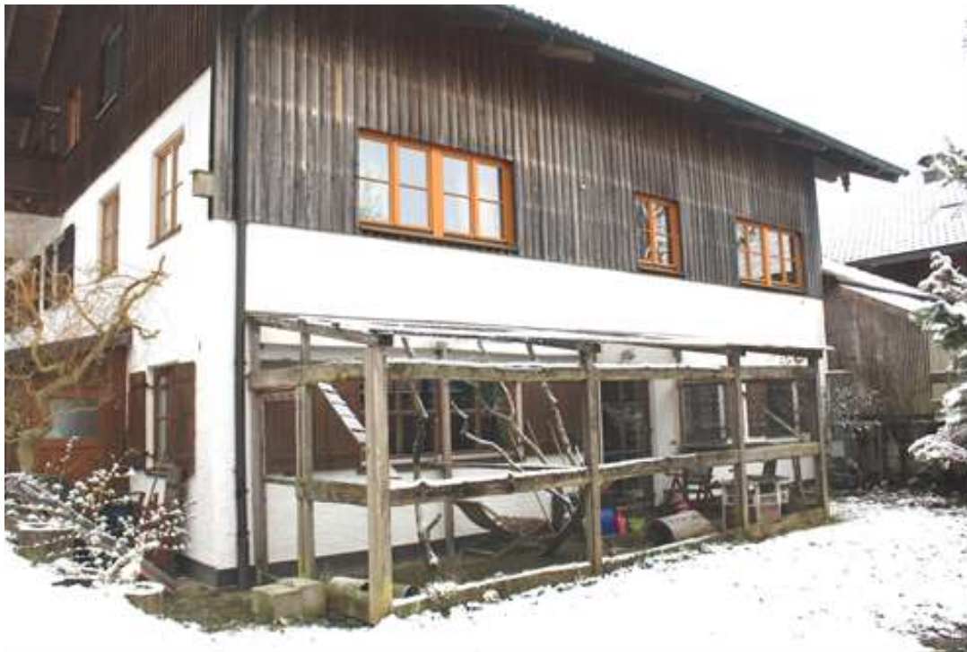
Abb. 8: Nordfassade, vom Plan abweichend, Vogelvoliere, verwitterte Holzteile, (beispielhaft)
