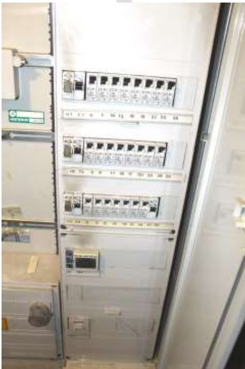
Abb. 24: Sicherungskasten
