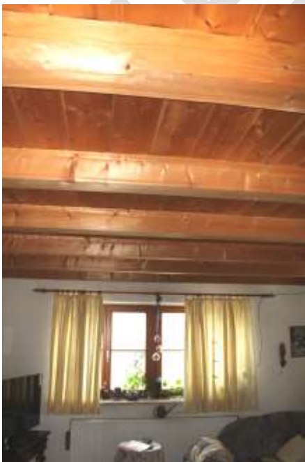
Abb. 30b: Decke Wohnzimmer
