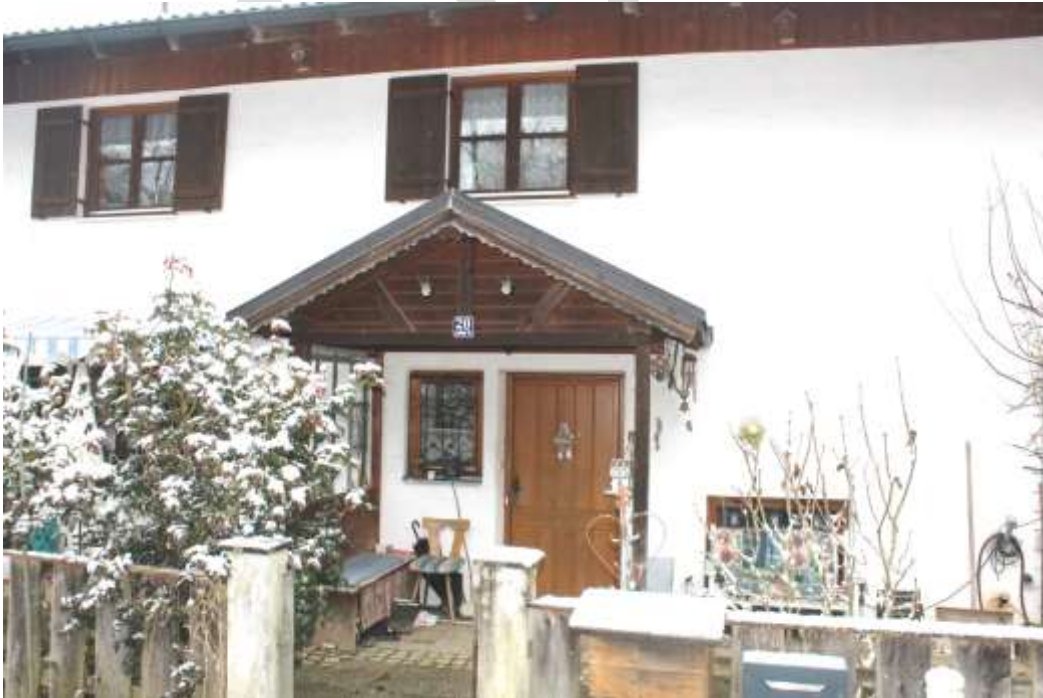
Abb. 3: Südansicht Detailaufnahme Eingang, vom Plan abweichende Gestaltung
