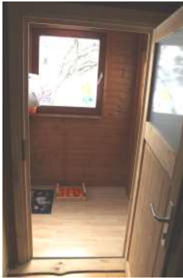
Abb. 10: Vorhaus innen - Wohnung KG/Sockelgeschoss (Ostseite)
