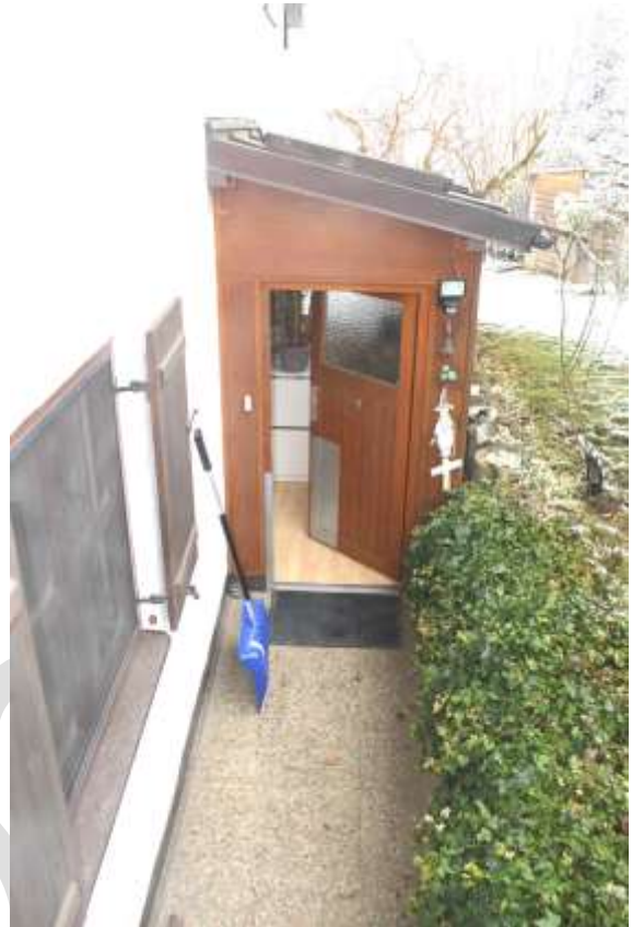
Abb. 6: Ostseite – Vorhaus Wohnung KG/Sockelgeschoss
