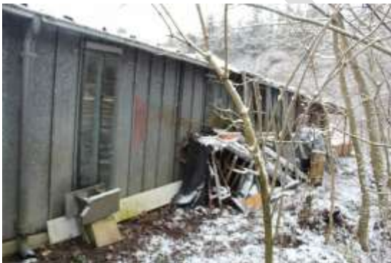
Abb. 47a: Stahlblechgaragen Rückseite
