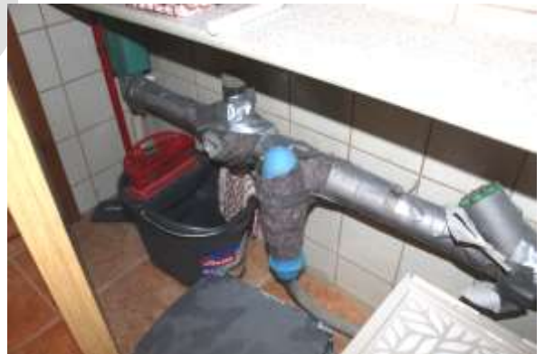
Abb. 16d: Rohrisolierung Duschbad
