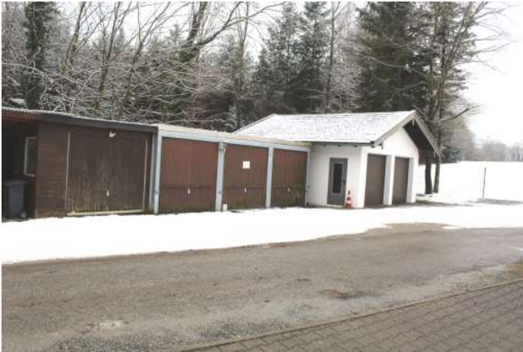
Abb. 44a: Grundstücksbebauung südlich des Wendelwegs, Garagentrakt
