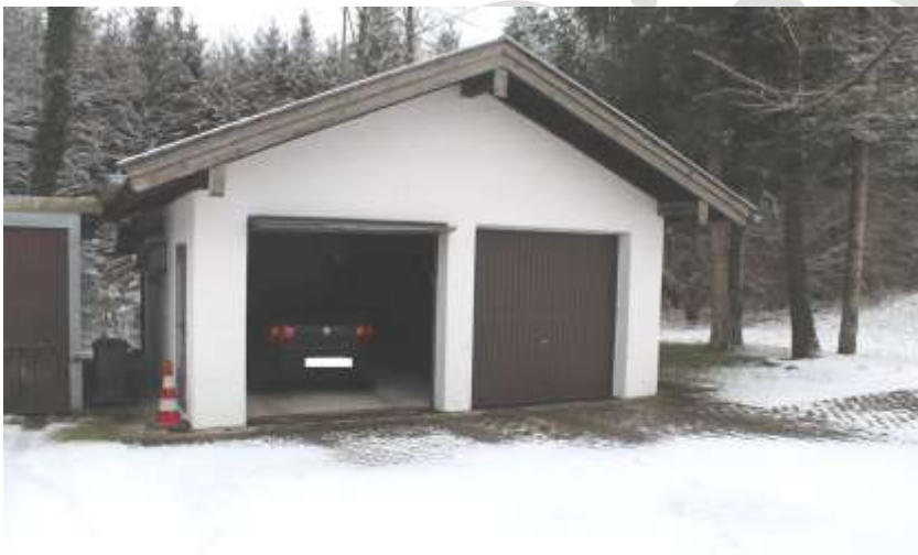
Abb. 46a: Nahaufnahme Doppelgarage
