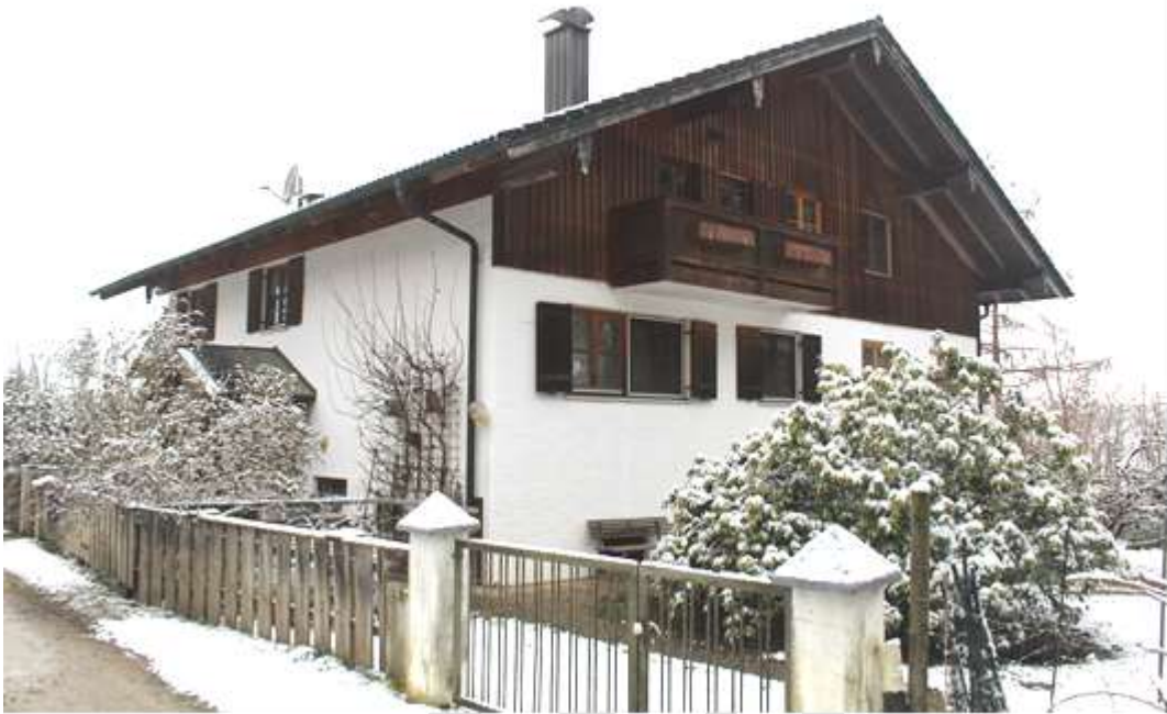
Abb. 4: Südostansicht, vom Plan abweichende Gestaltung
