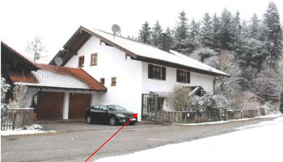
Abb. 1: Südwestansicht Haus Nr. 1 (Doppelgarage nicht auf FlNr. 2110!)
