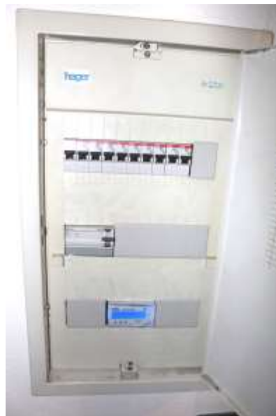
Abb. 43: Sicherungskasten DG
