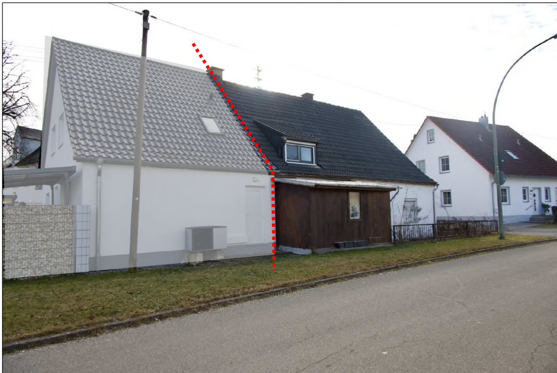
Foto 4 Ansicht von Nord-Osten
