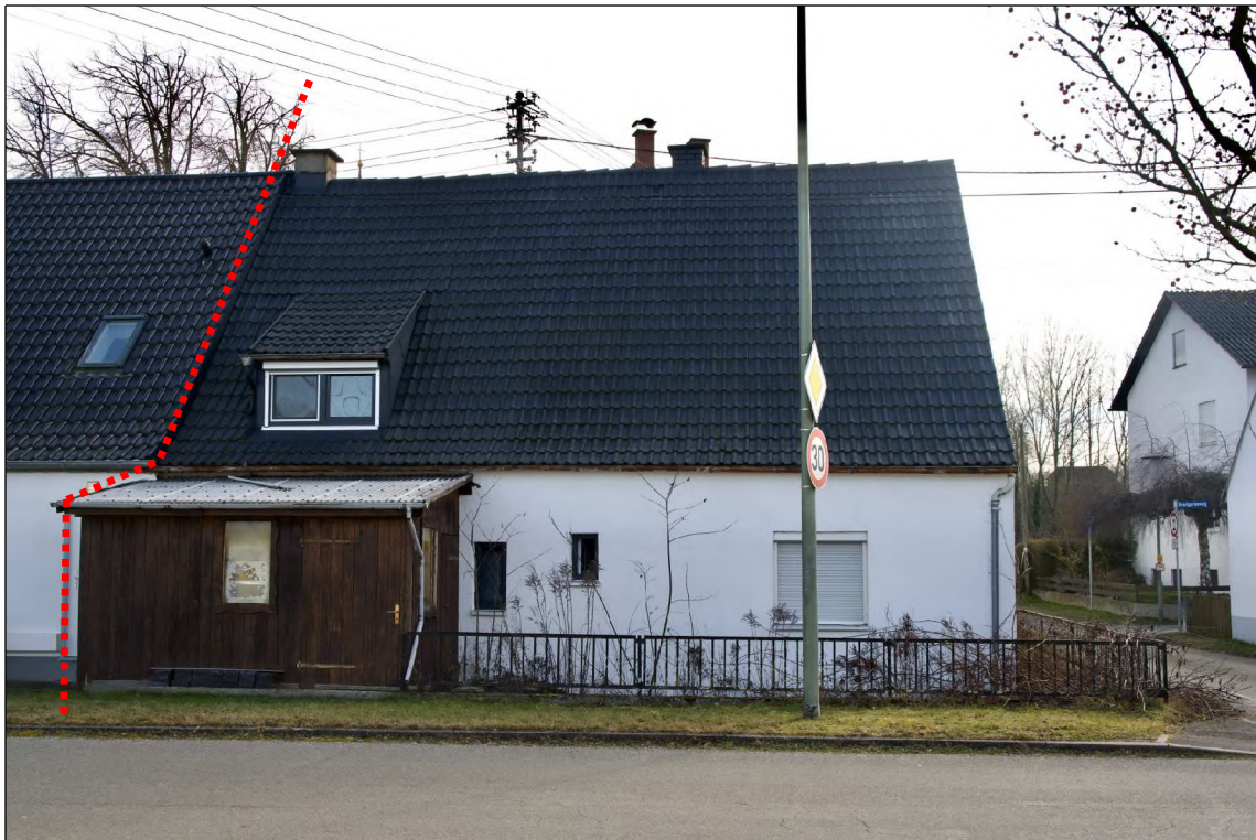
Foto 3 Ansicht von Norden (Feuchtwanger Straße)
