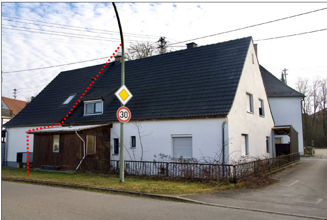
Foto 2 Ansicht von Westen
