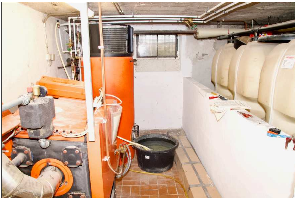
Foto 14 Kellergeschoss - Heizraum mit Öllager
