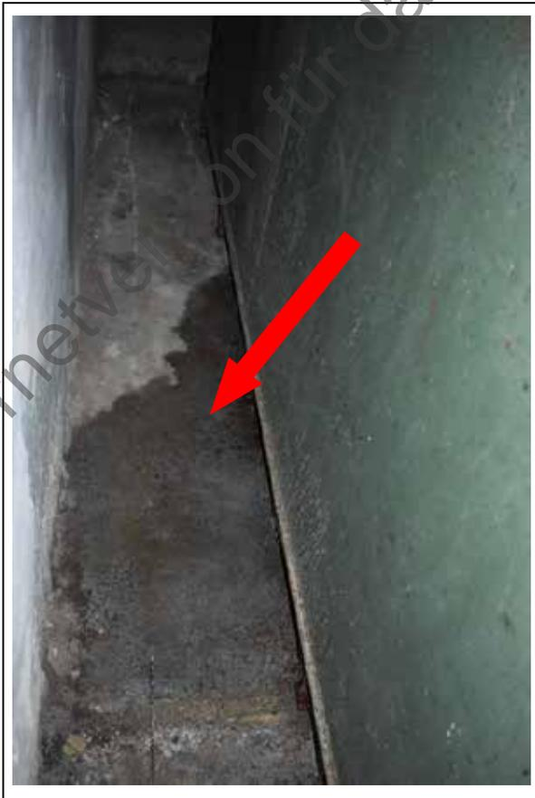
Foto 14: Wohnhaus, KG, Öltankraum mit Wasser am Boden
