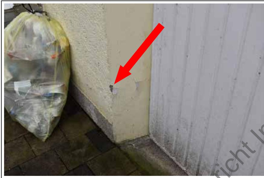
Foto 45: Nebengebäude mit Feuchtigkeitsschäden an der Fassade
