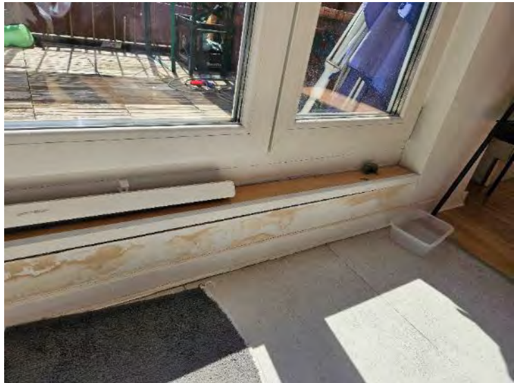
Balkontüre mit Feuchteschäden
