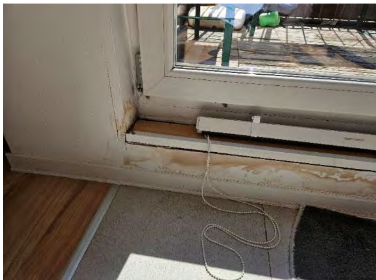
Balkontüre mit Feuchteschäden
