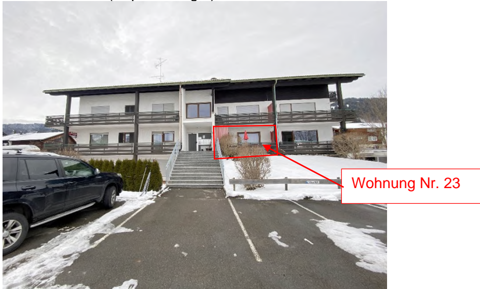
Bild 2 – Haus 2 (Kapellenweg 9) von Osten
