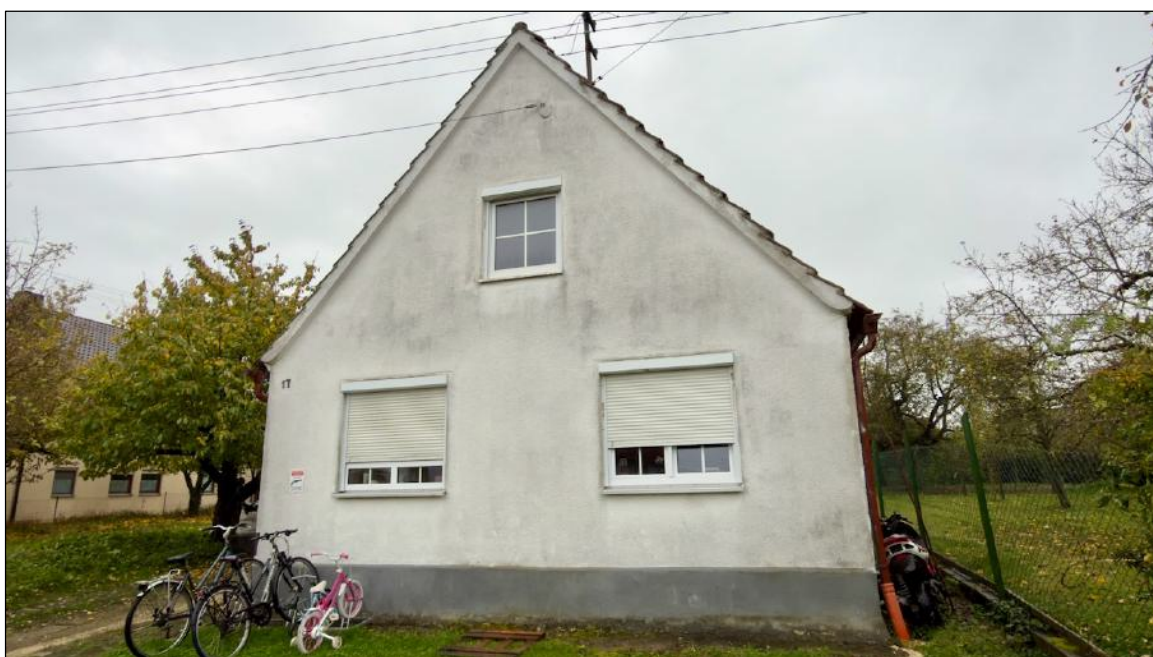
Foto 2 Ansicht von Norden
