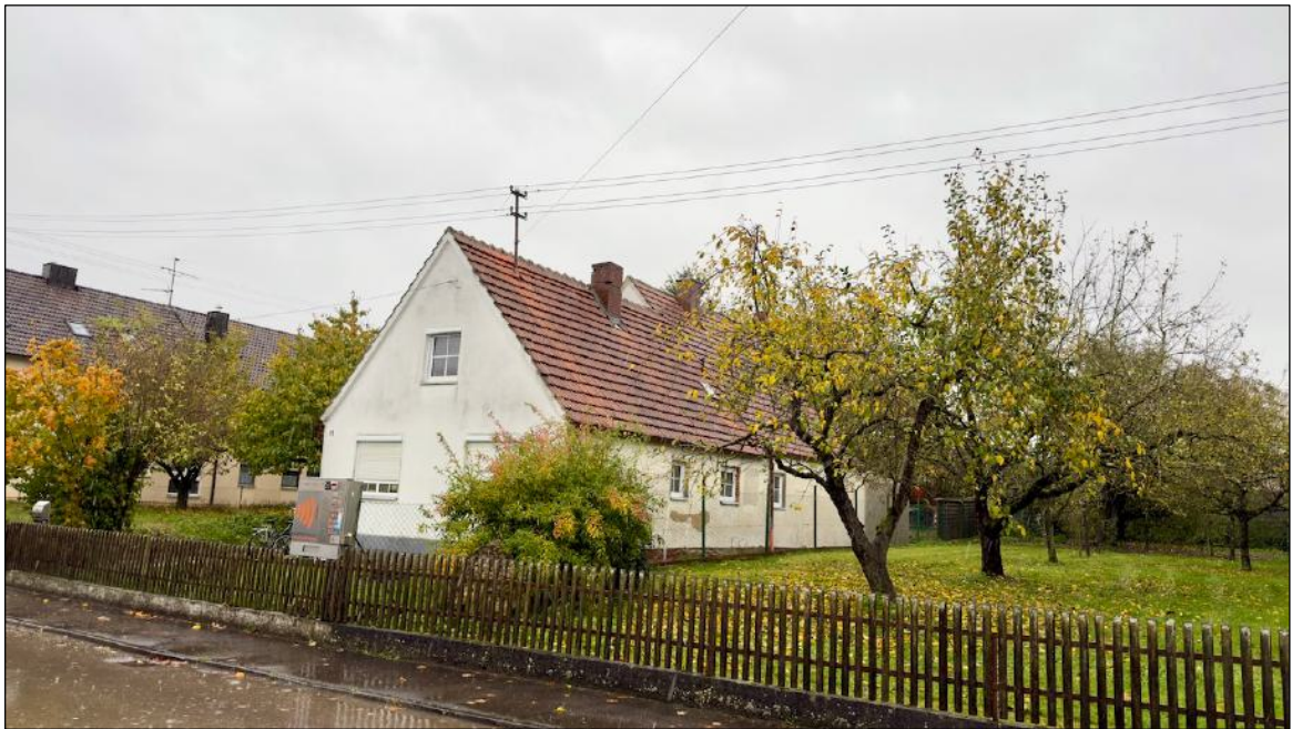
Foto 3 Ansicht von Westen
