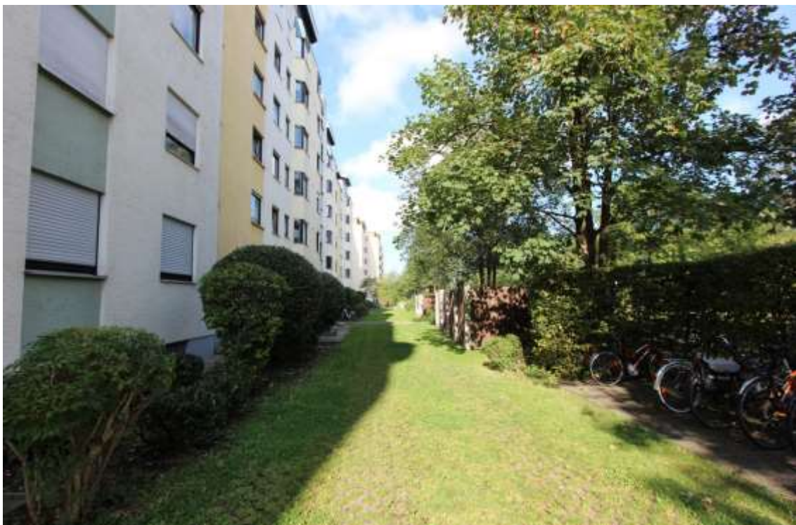
Außenanlagen Wohnanlage Norden
