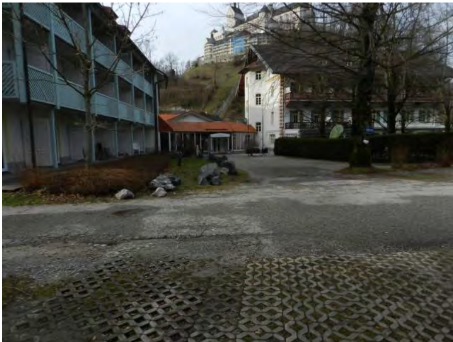
Blick entlang der Ostfassade auf Eingang
