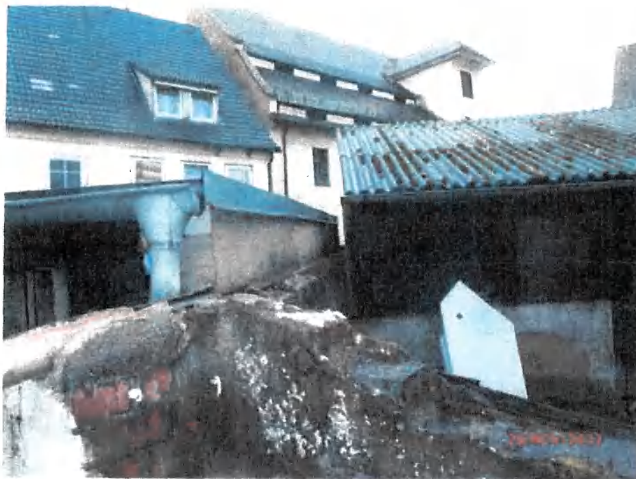
Bild 3: Grenzmauer (Dienstbarkeit) und linksständiges Carport
