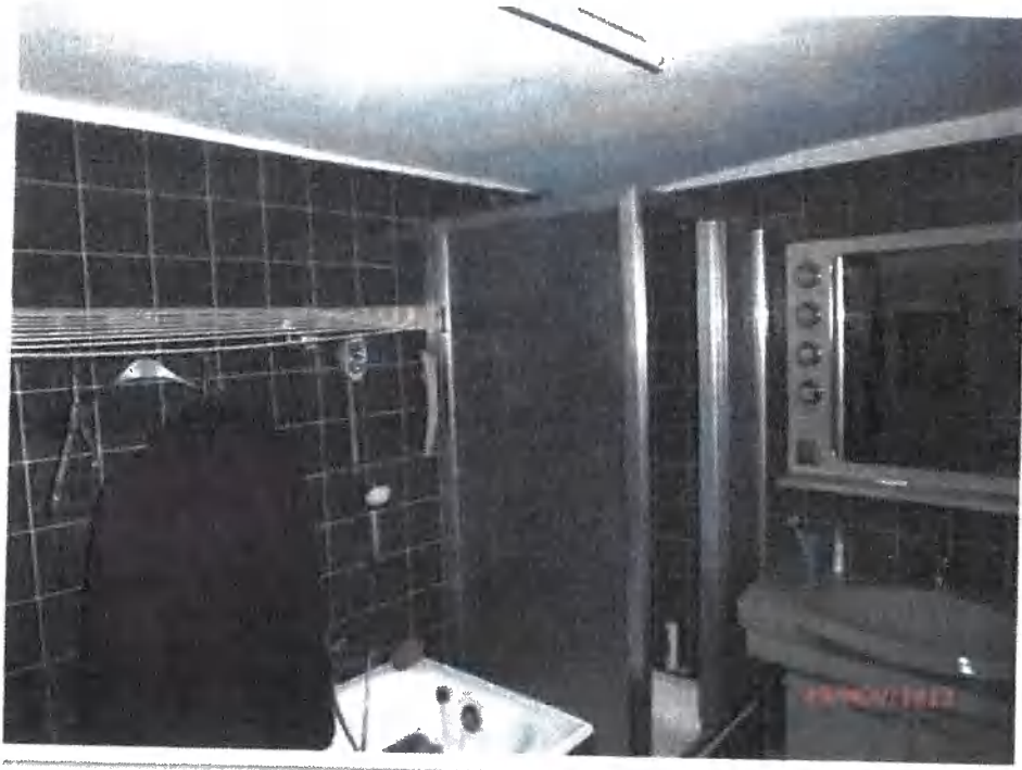
Bild 5: Badezimmer im Obergeschoss
