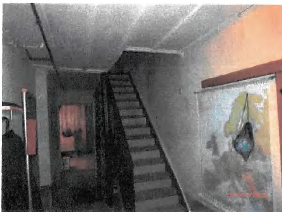
Bild 4: Flur Erdgeschoss mit Treppe zum Obergeschoss
