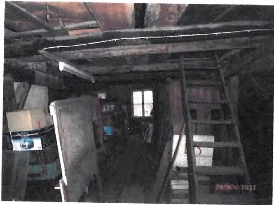
Bild 9: Nicht ausgebautes Dachgeschoss (Erreichbar über Einschubtreppe)
