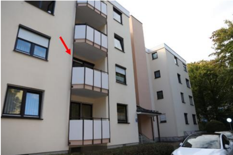
Außenansicht: Mehrfamilienhaus von Norden
