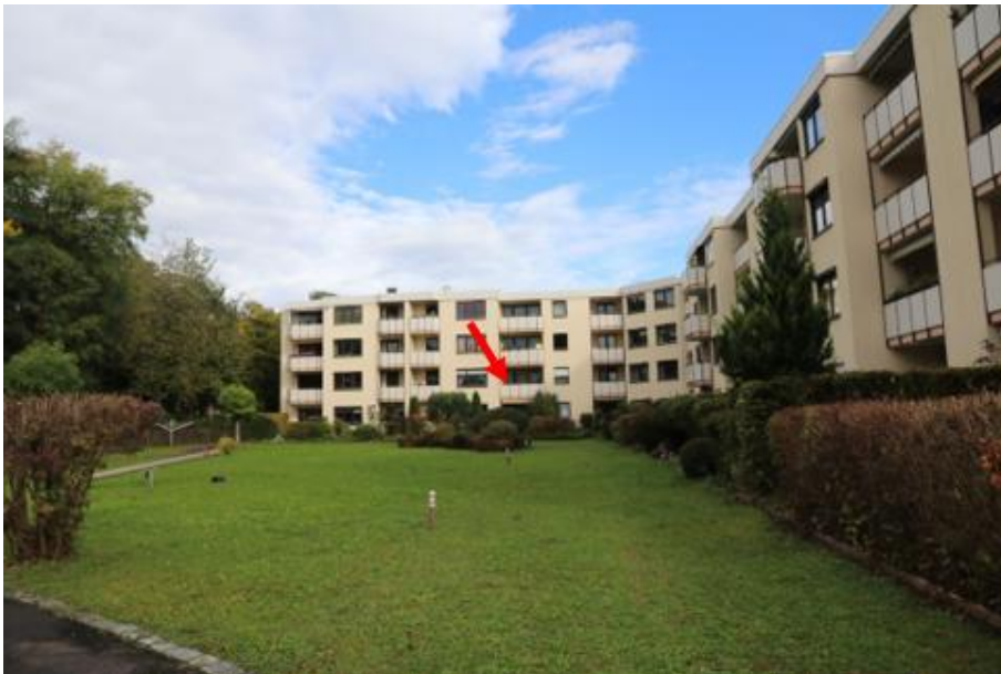
Außenansicht: Mehrfamilienhaus von Süden
