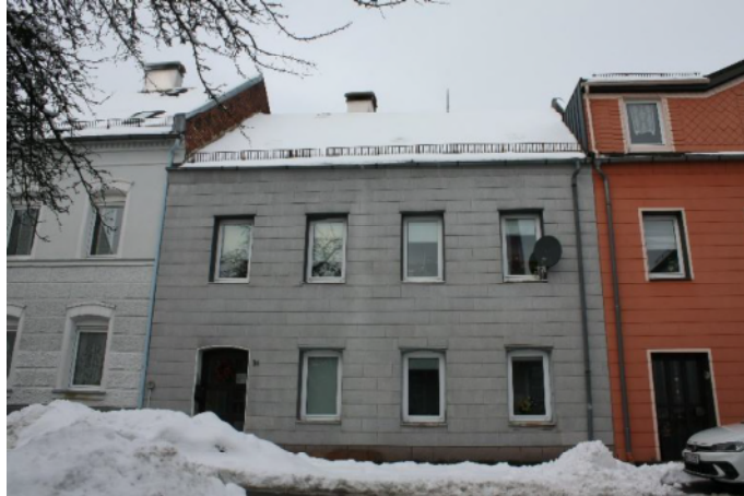
Ansicht des Gebäudes von der Schulstraße aus, links die Haustüre (s. Pfeil im Lageplan)
