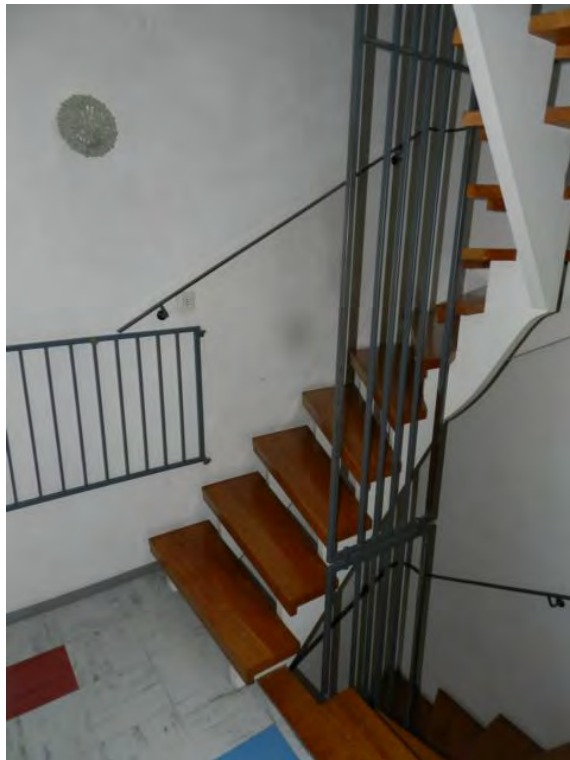
Treppe, OG zum DG bzw. EG
