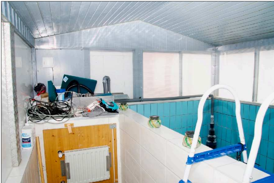
Foto 15 Dachgeschoss - Schwimmbecken oberhalb der Waschküche
