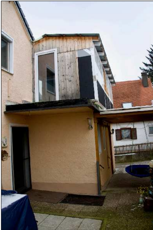
Foto 3 Ansicht von Süden, Waschküche mit Überbauung (Schwimmbecken)
