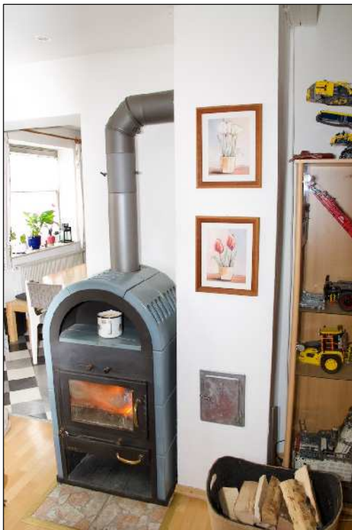
Foto 8 Erdgeschoss - stückholzbefuerter Einzelofen
