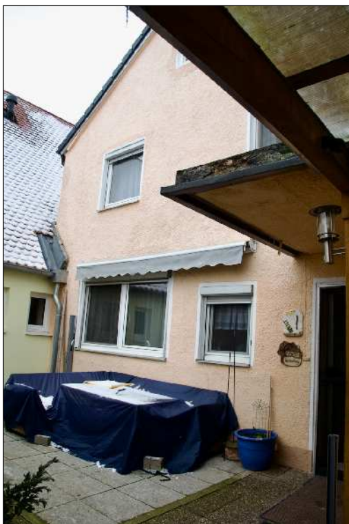
Foto 2 Ansicht von Süd-Westen, Terrasse
