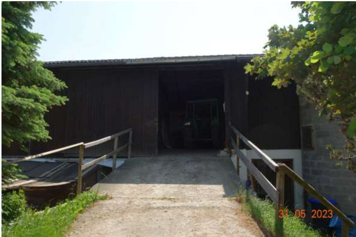
Abbildung 9: Betonrampe als nördliche Zufahrt zum DG des Wirtschaftsgebäudes
