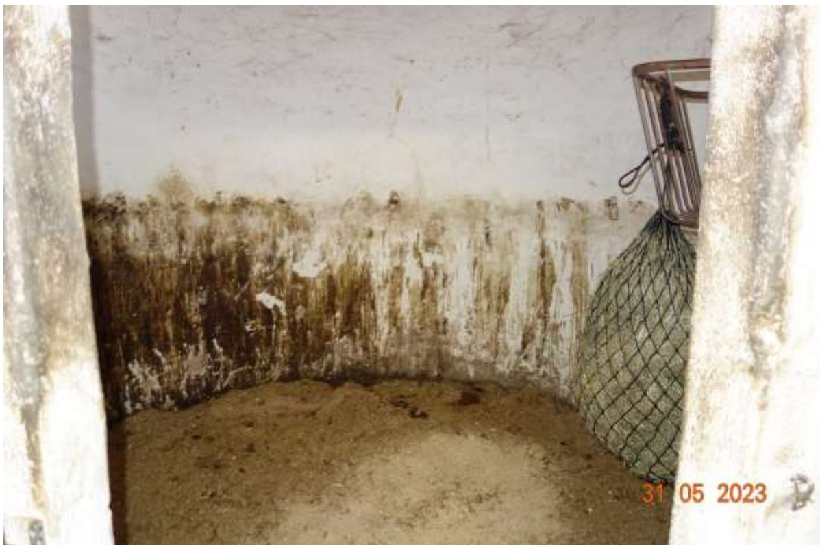
Abbildung 22: Pferdebox im Bereich eines früheren Futtersilos
