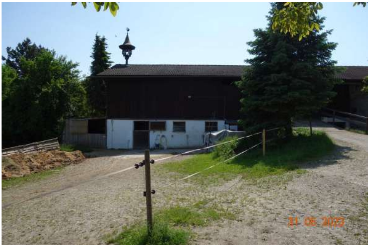
Abbildung 8: Nordseite des Wirtschaftsgebäudes mit Zugang zu den Pferdeboxen
