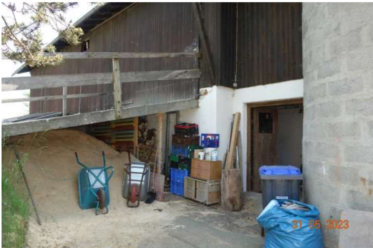
Abbildung 24: Zugang zu den Pferdeboxen und Rampe zum DG des Gebäudes
