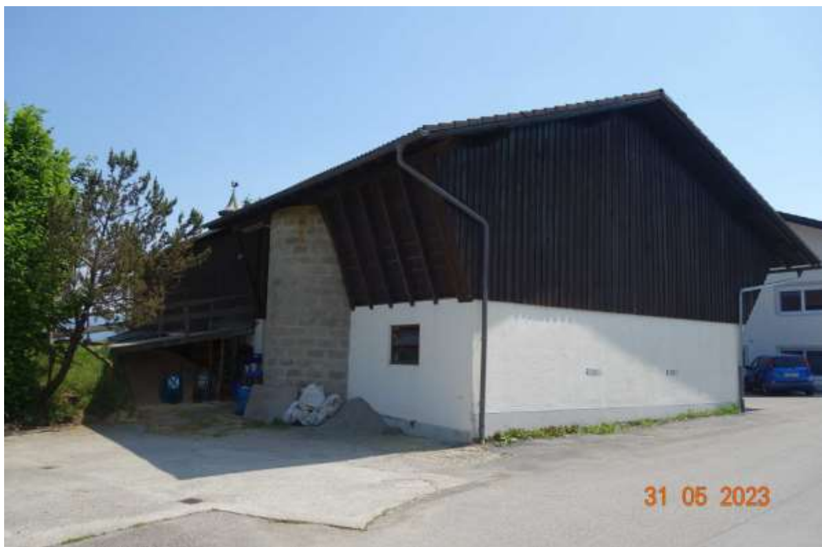
Abbildung 12: Nordwestliche Ansicht des Wirtschaftsgebäudes
