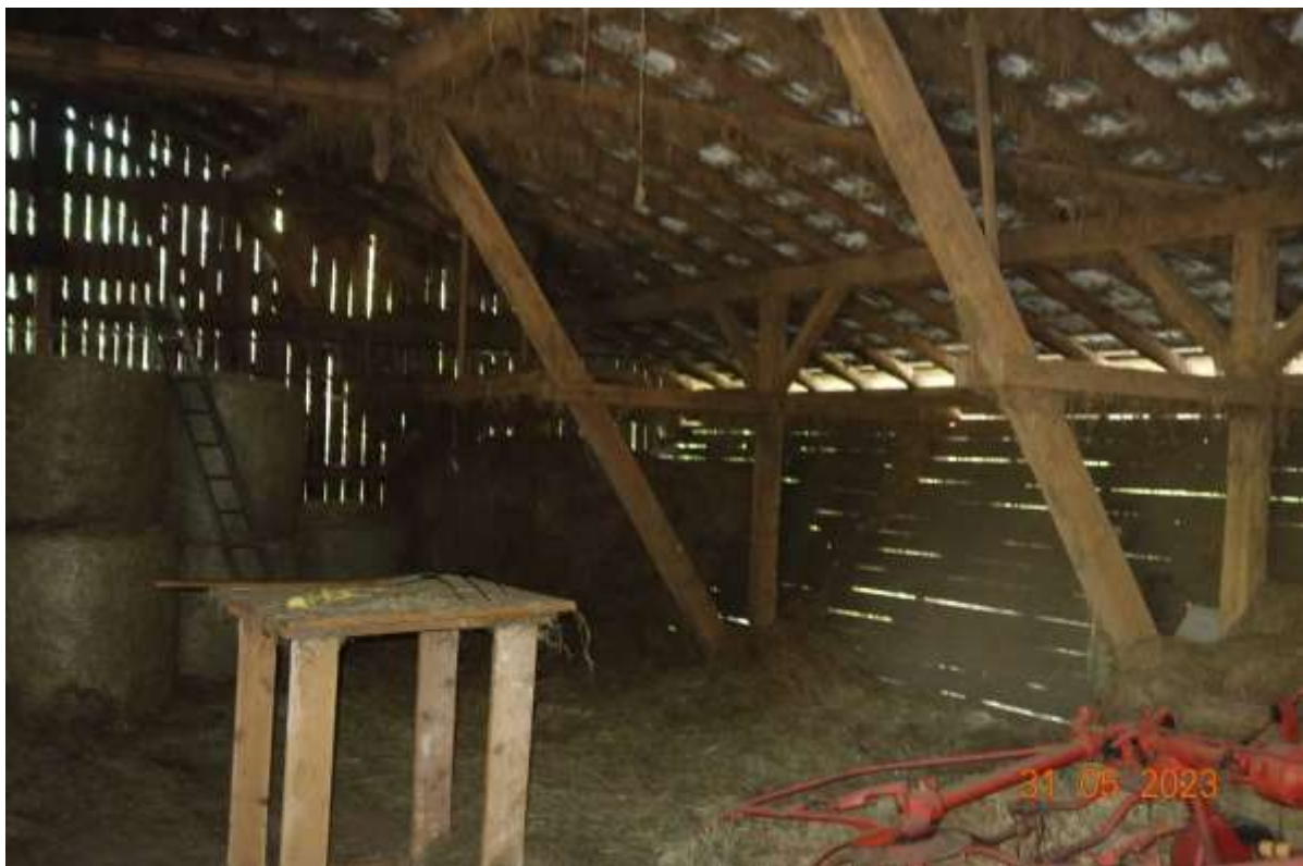
Abbildung 10: Heulager im DG des Wirtschaftsgebäudes
