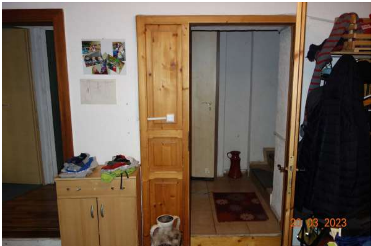
Abbildung 12: Wohnungsabschlusstür der Wohnung Nr. 2
