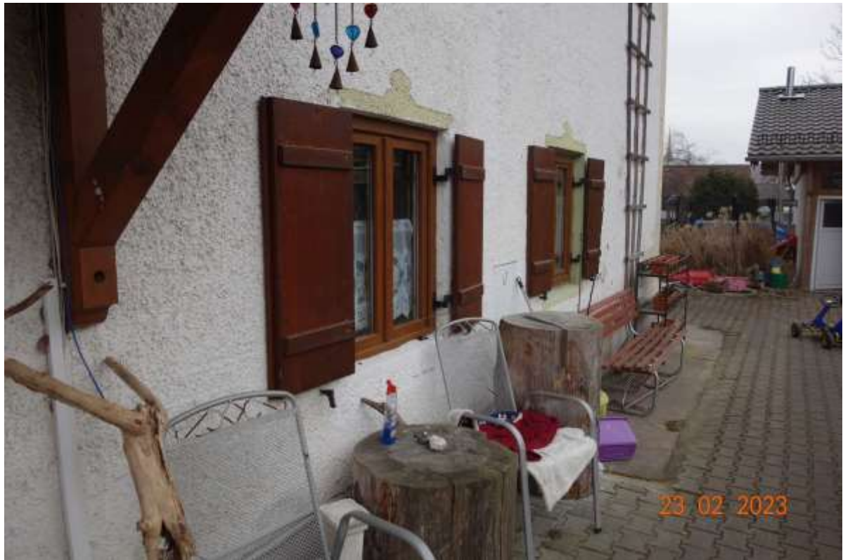
Abbildung 5: Nördliche Fassade im EG
