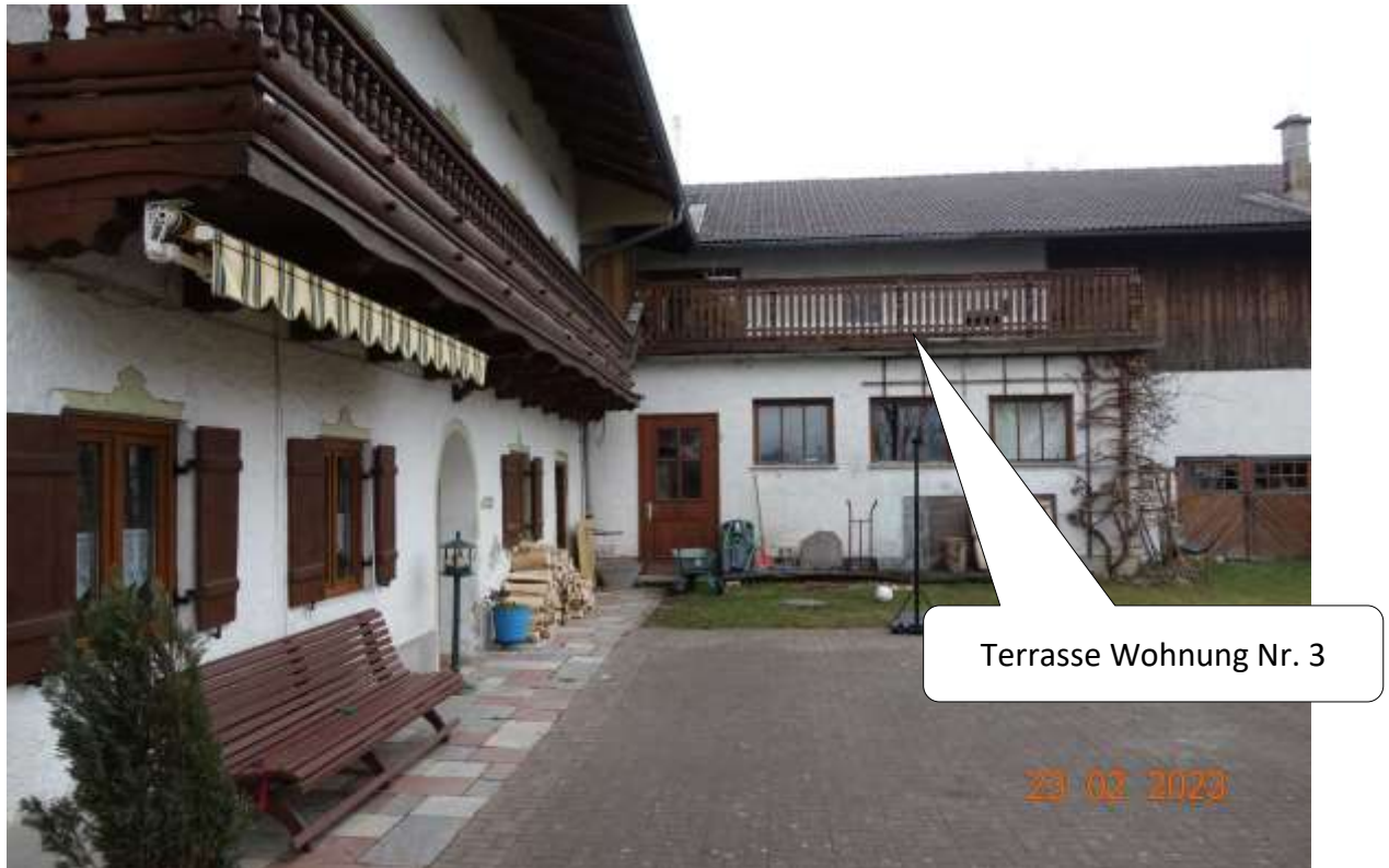
Abbildung 7: Südliche Fassade mit Balkon der Wohnung Nr. 1 und Terrasse der Wohnung Nr. 3
