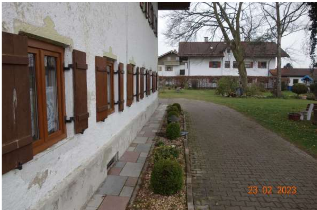
Abbildung 6: Westliche Fassade im EG
