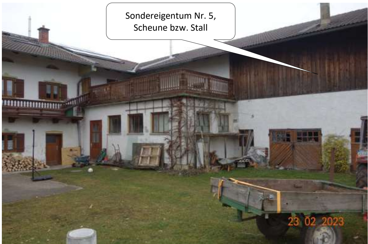
Abbildung 8: Terrasse der Wohnung Nr. 3 im Nebengebäude (Scheune bzw. Stall)
