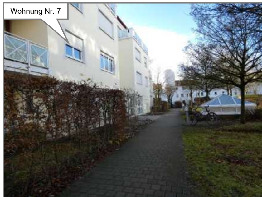
Zuwegung zum Hauseingang Hausnummer 19c an der Nordwestfassade - Blick nach Südwesten
