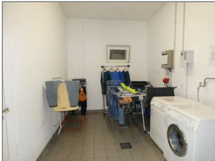
Hausnummer 19c - Kellergeschoss - Wasch-/Trockenraum
