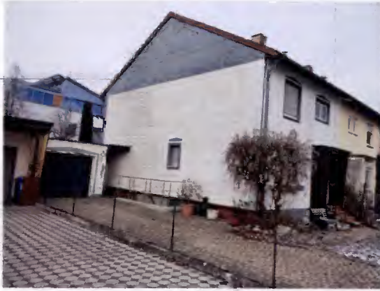
Südwestseitige Giebelassade, sowie südostseitige Trauffassade, Wohngebäude. Links im Bild das Garagengebäude
