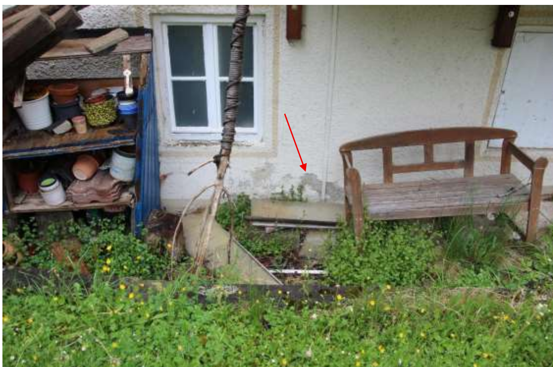
Detailansicht Fassade mit Farbabplatzungen am Sockel
