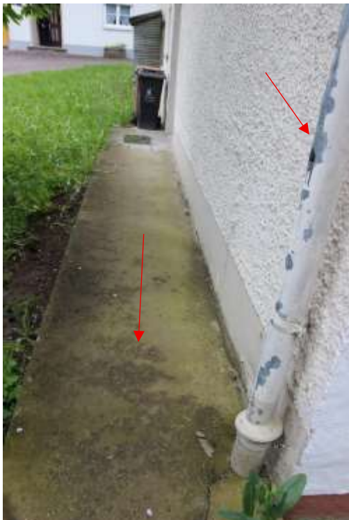
Zuwegung mit Abwitterungen und Farbabplatzung Fallrohr
