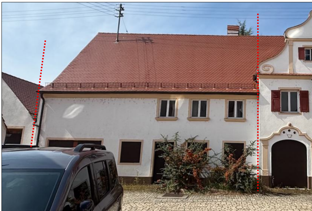
Foto 7 Ansicht von Norden
