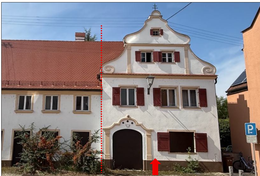
Foto 8 Ansicht von Norden
