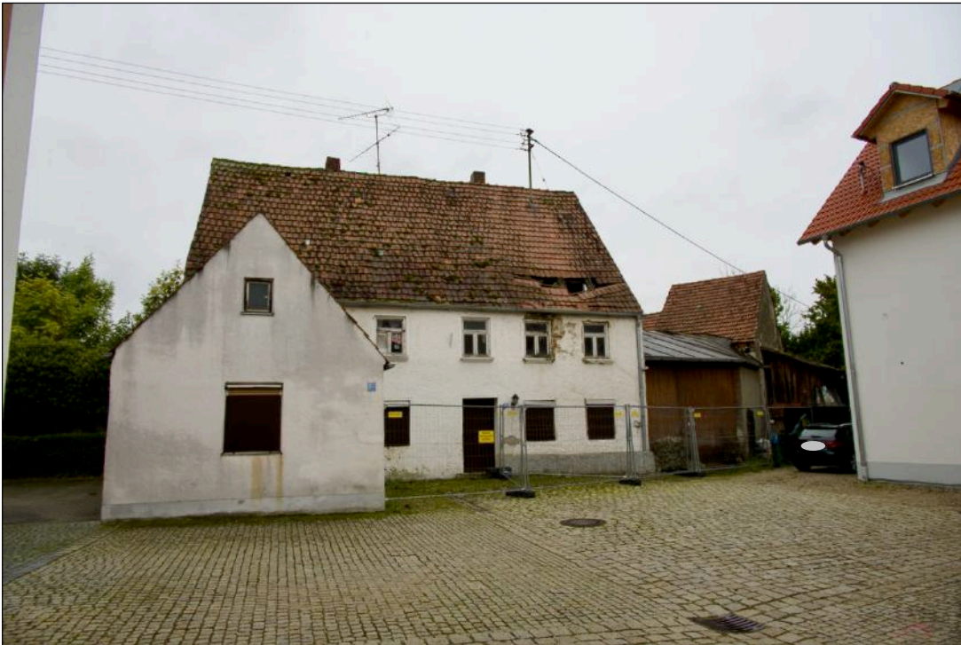
Foto 4 Ansicht von Norden
