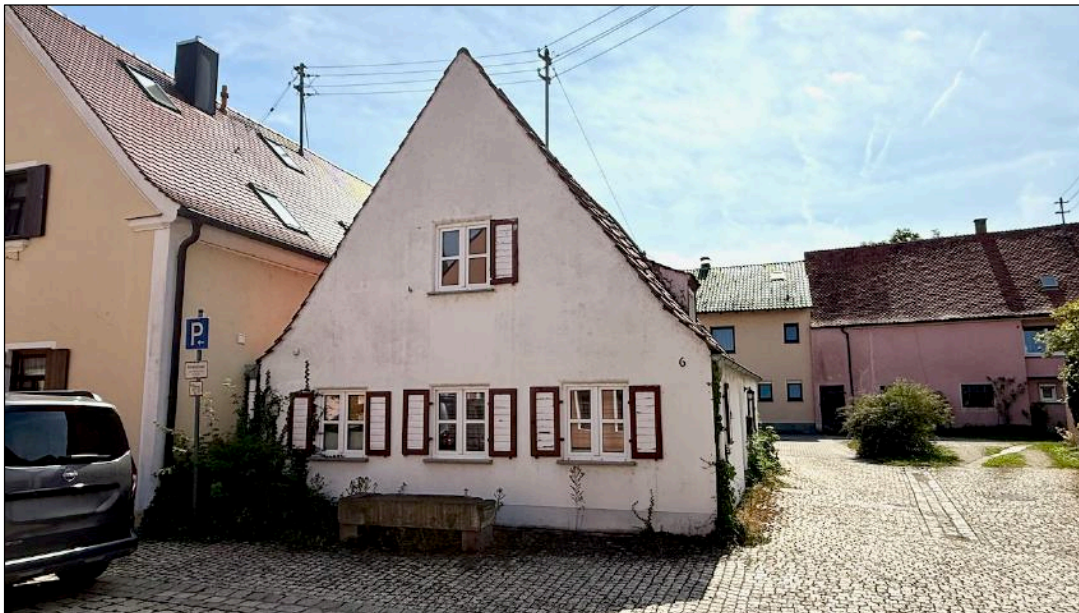
Foto 1 Ansicht von Norden
