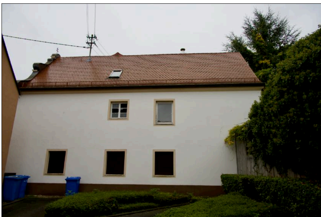
Foto 9 Ansicht von Westen
