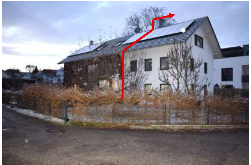
Ansicht aus Richtung Südosten
