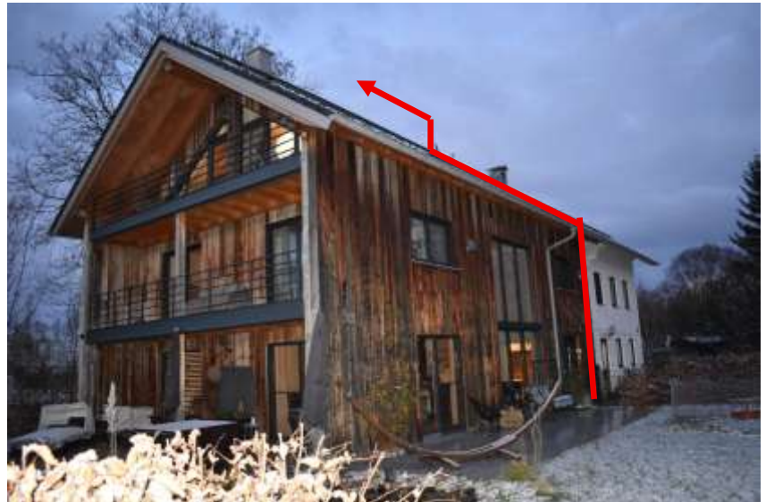
Ansicht aus Richtung Südosten
