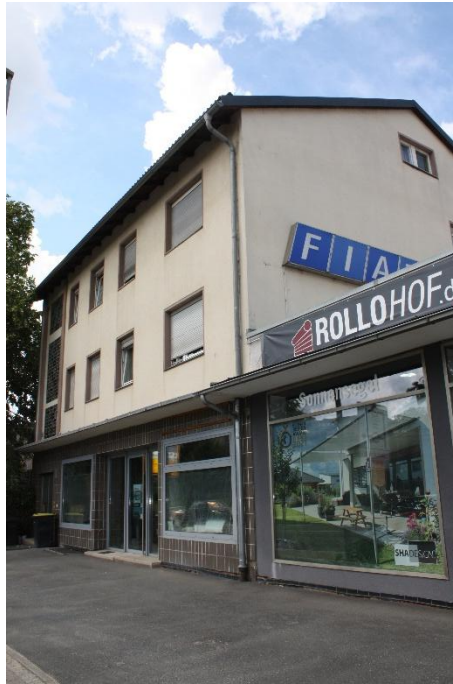
die Ostseite des Zweifamilienwohnhauses mit der früheren Ausstellungshalle im Erdgeschoss
