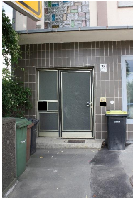
die Hauseingangstüre zu dem Gebäude Lessingstraße 25
