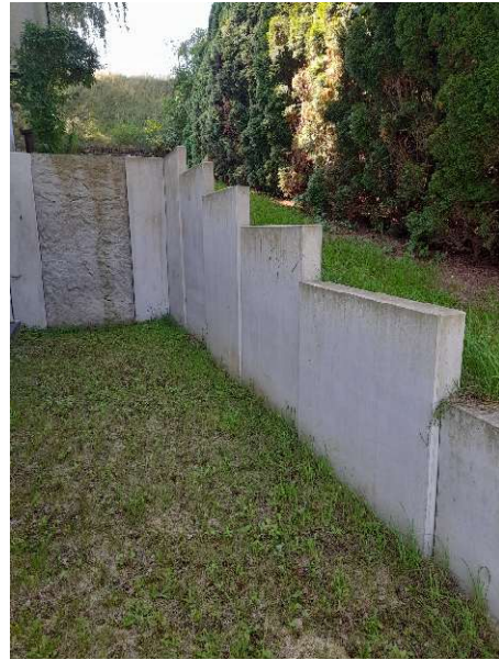
Bewertungsobjekt fehlende Terrasse mit vorhandene Stützwände
