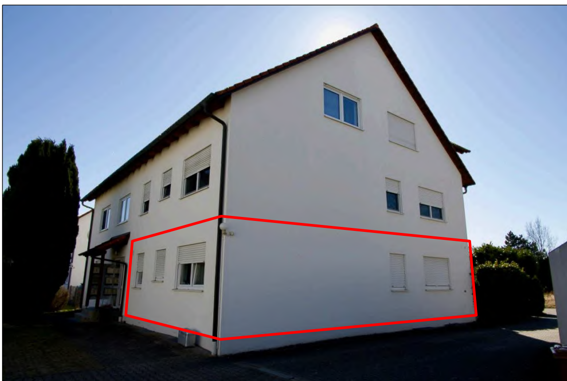
Foto 2 Ansicht von Norden
