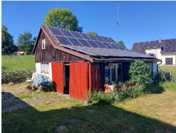
Schuppen mit Photovoltaikanlage Süd-West-Ansicht
