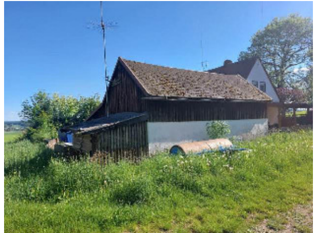
Schuppen und Holzverschlag Nord-Ost-Ansicht
