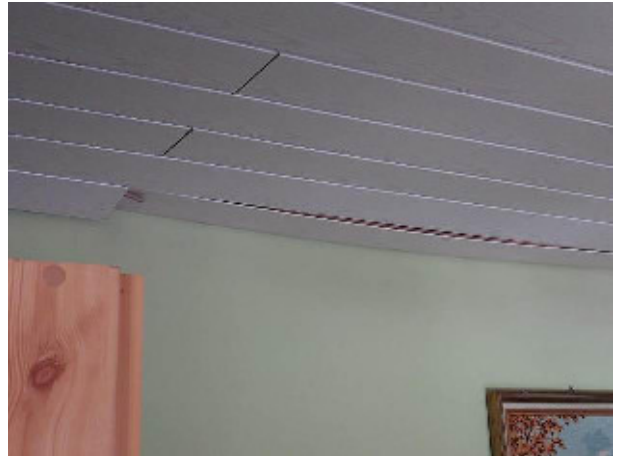
schadhafte Holzbauteile
