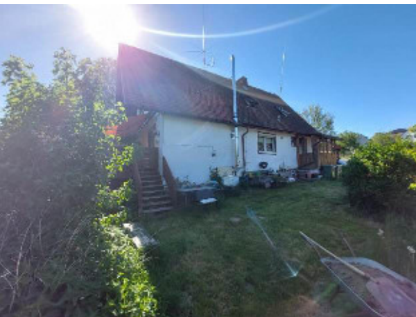
Süd-Ost-Ansicht Überbau auf Flst. 875/2 von Terrasse und Dachüberstand
